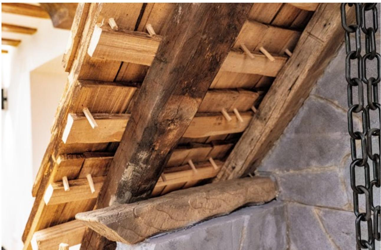
The shingles are attached to the *latas* or battens with wooden pegs. View from the interior | Las tablillas se cuelgan de las *latas* o rastreles mediante clavijas de madera. Vista desde el interior | As telhas de madeira penduram-se nas *latas* ou ripas utilizando cavilhas de madeira. Vista a partir do interior (Javier Ochoa)
