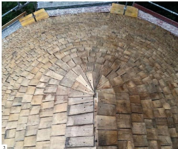
1: The finished beech shingle roof. 2: Shingle tiling over the apse | 1: El tejado de tablilla acabado. 2: Las tablillas del ábside | 1: O telhado de telhas de madeira depois de acabado. 2: As telhas da abside (Javier Goicoa)
