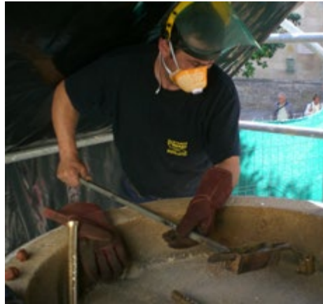
Emplomado de los caños de bronce durante la restauración de una de las siete fuentes históricas de Santiago de Compostela
