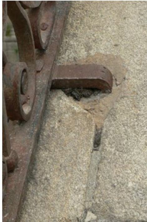
Estado previo y posterior a la restauración de una mala fijación de una reja a una losa de piedra
