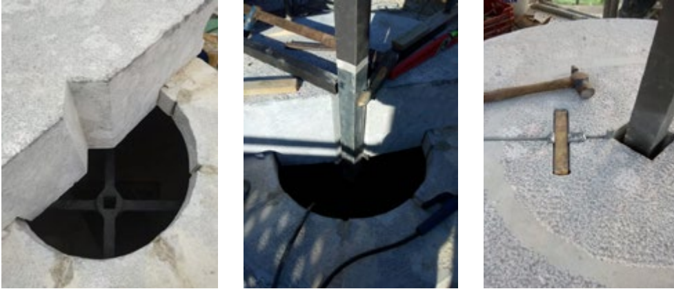
Proceso de fijación de un vástago en la cruceta que lo ancla a la cúpula y grapa que une las dos piezas que conforman la pieza superior de la cúpula
