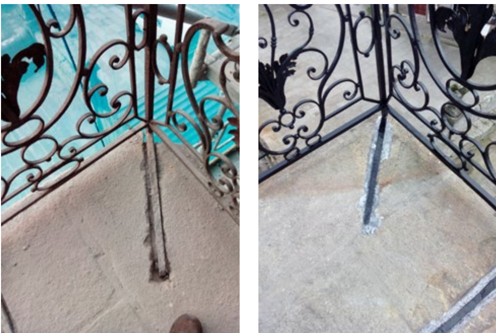
Restauración de la fijación con plomo de una baranda a una losa de piedra
