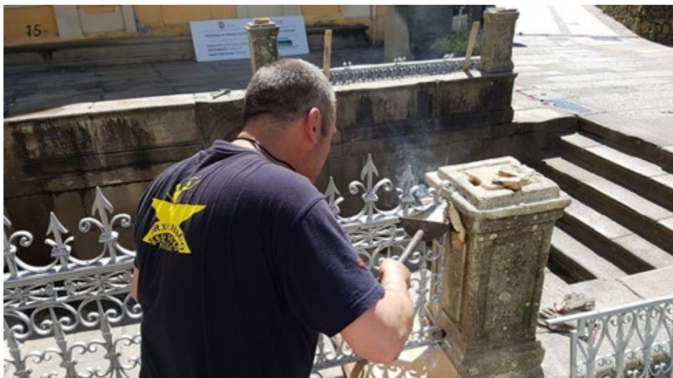
Vertido de plomo líquido para la fijación de una rejería histórica en las Burgas de Caldas de Reis, Pontevedra
