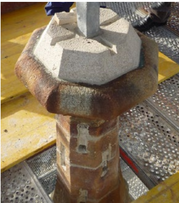
Colocación del vástago interno de un pináculo para fijar sobre él una bola
