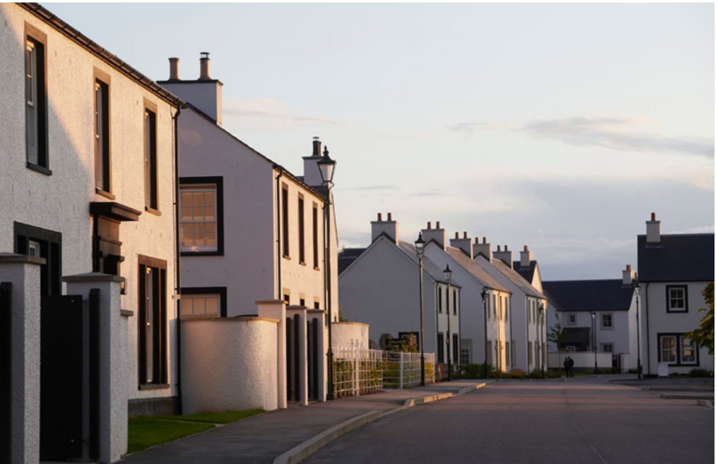
For main streets in Phase 1 a simple palette was used: white roughcast render with black window and door surrounds | En las calles principales de la primera fase se utilizó una paleta simple: enfoscado en mortero blanco con marcos de puertas y ventanas en color negro | Para as ruas principais da Fase 1, foi utilizada uma paleta simples: chapisco branco com janelas e portas pretas (Ewen Wetherspoon)
