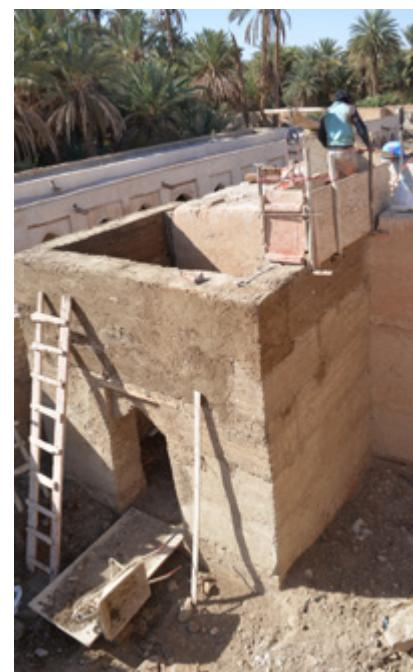
**Construction of adobe arches with metal formwork, and of rammed-earth walls | Construcción de arcos de adobe con cimbras metálicas y construcción de muros con tapial | Construção de arcos de adobe com cimbre metálico e construção de paredes de taipa**
