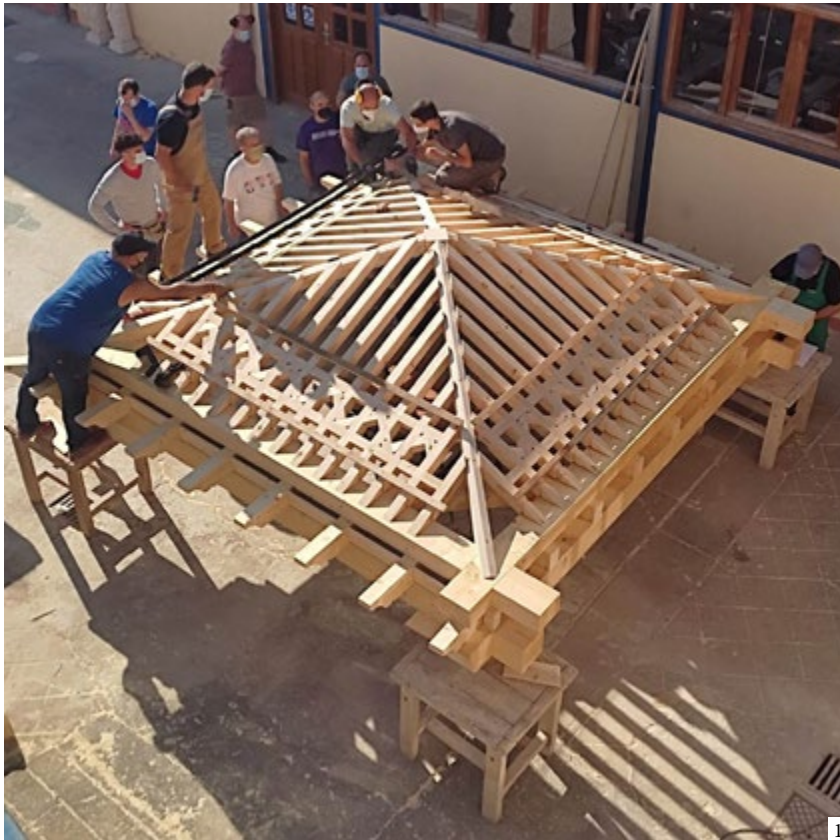
1: Carpentry workshop at the León Trades Center. Building of one slope of the new porch roof. Structural carpentry course, summer 2020 2: Workshop assembly of the new porch roof structure 3: Corner detail of the top plating for the new main porch structure, with footings, sill plates, beams, wall plates, and a corner crosspiece | 1: Taller de carpintería del Centro de los Oficios de León. Construcción de un faldón de la nueva armadura del pórtico sobre la entrada principal. Curso de carpintería de armar, verano de 2020 2: Montaje en el taller de la nueva armadura del pórtico principal para la iglesia de Santiago Apóstol 3: Detalle de la esquina del estriado de la nueva armadura del pórtico principal, con zapatas, soleras, cabezuelas, estribos y cuadral | 1: Oficina de carpintaria do Centro de Ofícios de León. Construção de uma das águas do novo telhado do pórtico. Curso de carpintaria estrutural, verão de 2020. 2: Montagem na oficina da nova estrutura do pórtico principal para a igreja de Santiago Apóstol. 3: Pormenor do canto do pilar do novo reforço do pórtico principal, com sapatas, soleiras, vigas, frechais e escoras
