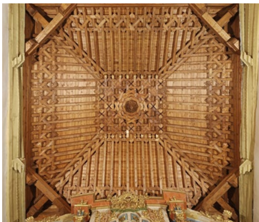
New roof structure over the chancel | Nueva armadura de cubierta del presbiterio | Nova estrutura do tecto do presbitério
