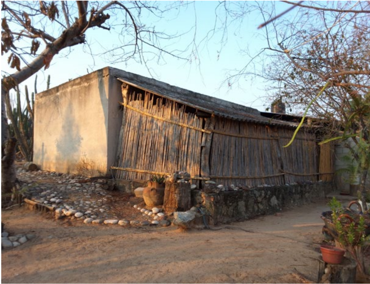
Figura 3: Arquitectura vernácula en Tonahuixtla, Puebla: casa de adobe con corredor de chiname
