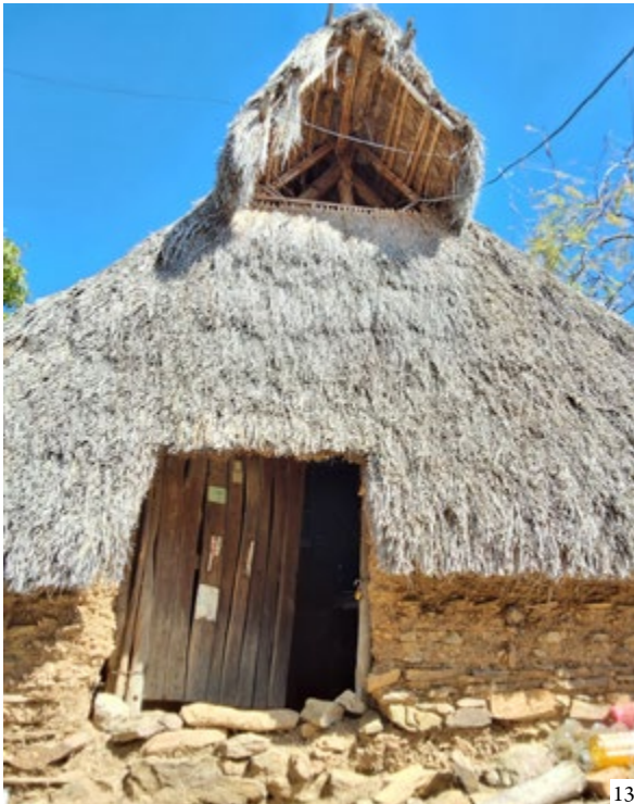
Figura 12: Casa con muros de chiname y techo de palma en San Jerónimo Xayacatlán, Puebla
