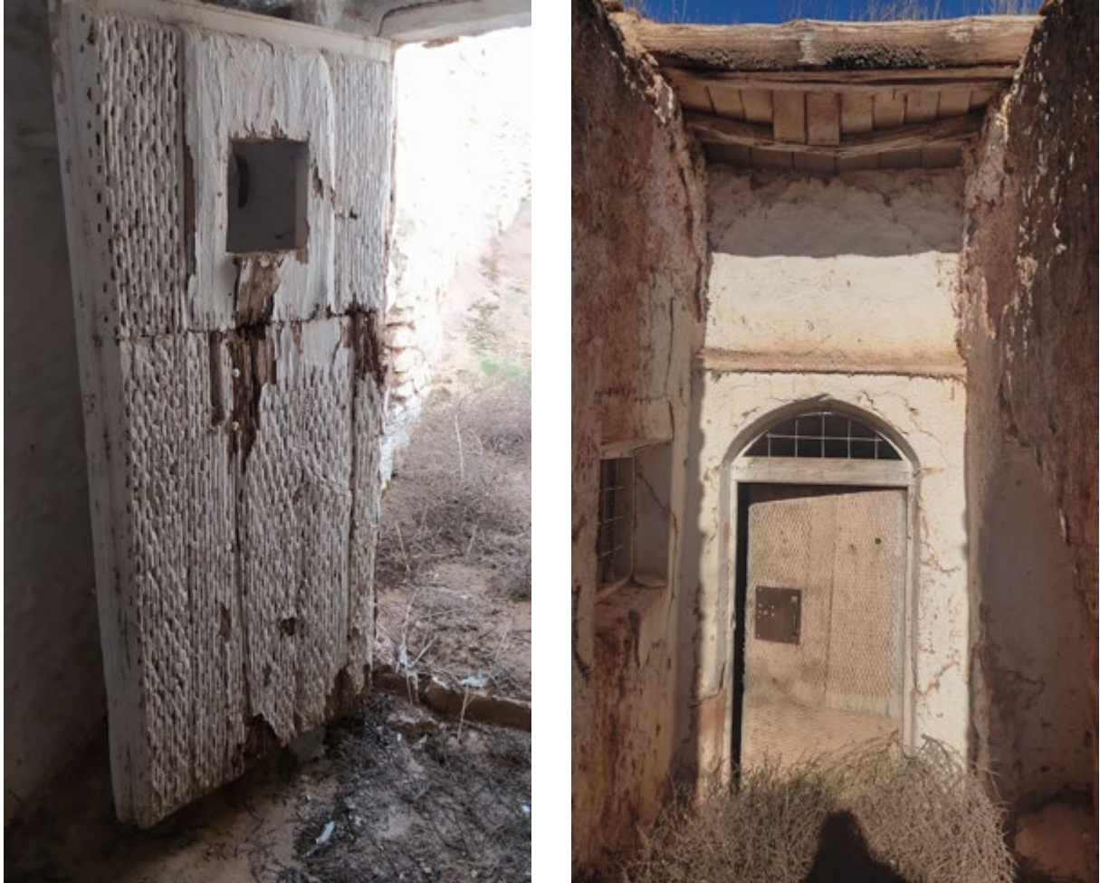
Figura 11: Puerta de entrada a la cueva con orificio de ventilación en la puerta o sobre el dintel. Cueva en el paraje de Las Mayorgas y cueva en el paraje de la Casa de Don Diego (Manzanares) (David Cejudo e Iván Acosta)
