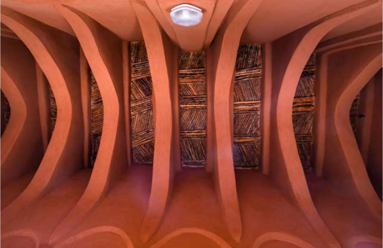
Adobe and timber structure of the library | Estructura de adobe y madera de la biblioteca | Estrutura de adobe e madeira da biblioteca (James Wang)
