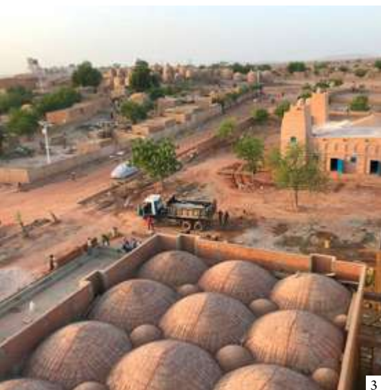
1, 2: Construction with compressed earth blocks 3: View of the extrados of the CEB vaults 4: Work team | 1, 2: Construcción con bloques de tierra comprimida 3: Vista del trasdós de las bóvedas de BTC 4: Equipo de trabajo | 1, 2: Construção com blocos de terra comprimida 3: Vista do extradós das abóbadas de BTC 4: Equipa de trabalho
