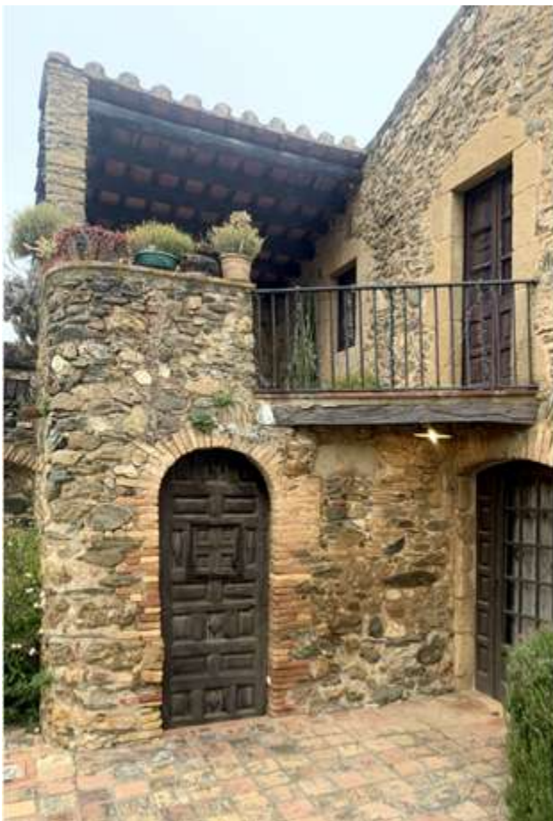
Southwest corner before and after the restoration | Esquina suroeste antes y después de la intervención | Canto sudoeste antes e depois da intervenção (2: Antonio Navarro Wijkmark)
