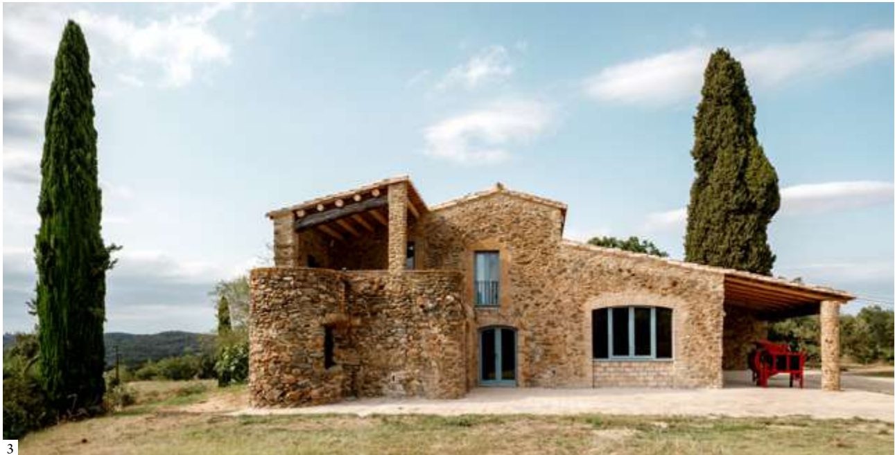
Main façade before and after the restoration | Fachada principal antes y después de la intervención | Fachada principal antes e depois da intervenção (1, 2: Archivo Bangolo 3: Antonio Navarro Wijkmark)
