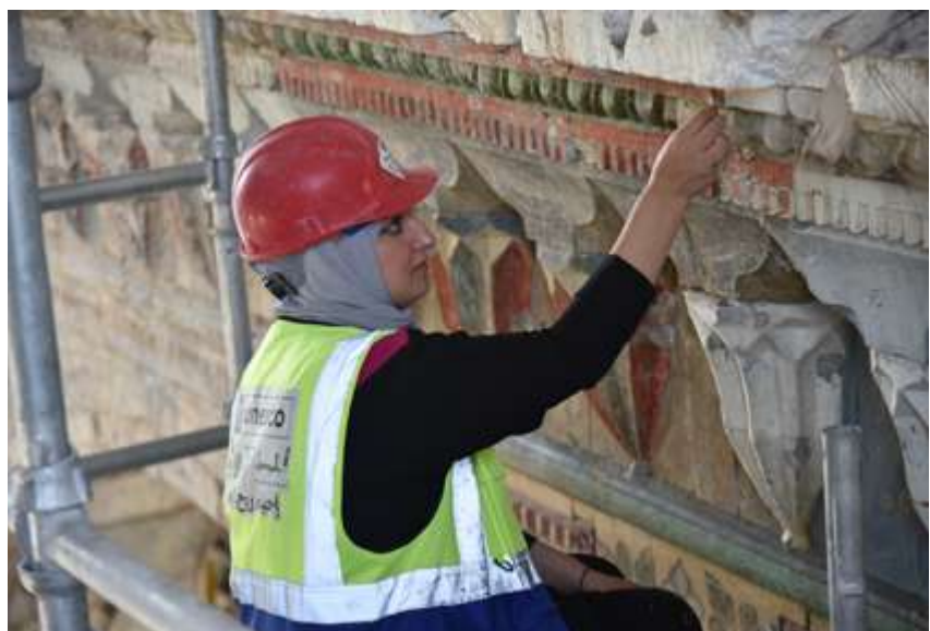
Conservation works | Trabajos de conservación | Trabalhos de conservação (Abdullah Rashid)
