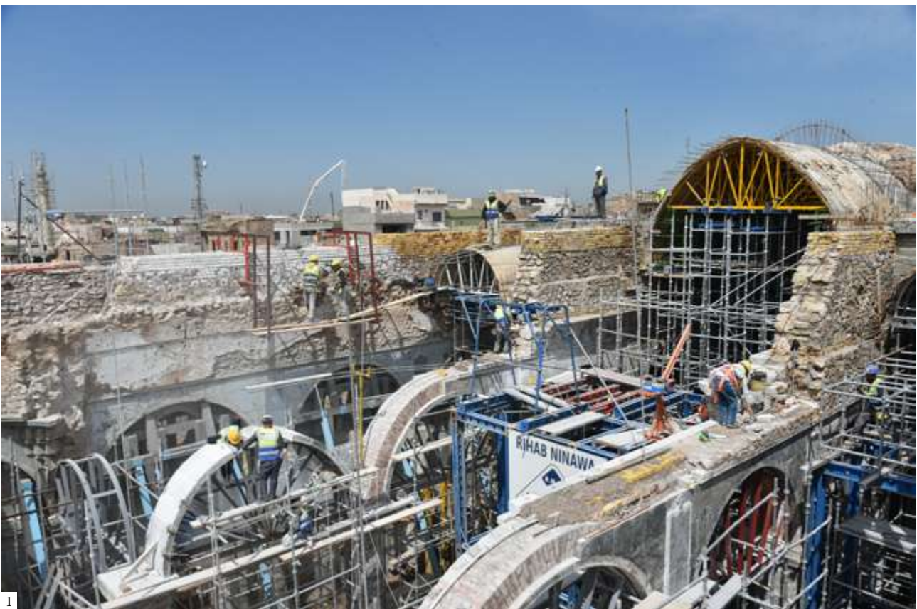
1: Reconstruction of the vaults 2: Construction of the brick wall 3: Construction of the limestone arch | 1: Reconstrucción de las bóvedas 2: Construcción del muro de ladrillo 3: Construcción del arco de piedra caliza | 1: Reconstrução das abóbadas 2: Construção do muro de tijolo 3: Construção do arco de pedra calcária (1, 2: SBAH team 3: Abdullah Rashid)
