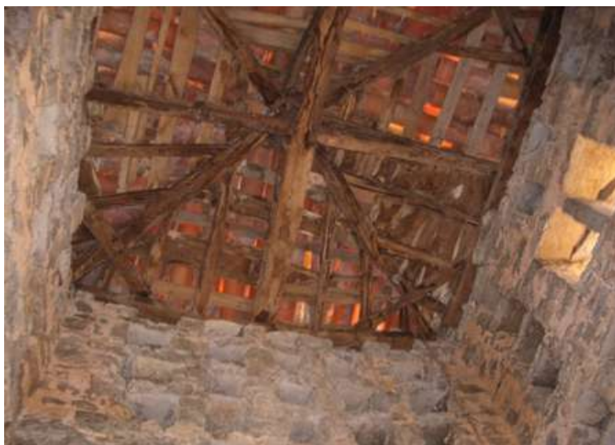
Figura 9: Interior del palomar de la antigua rectoral en Tresmonte, Les Regueres
