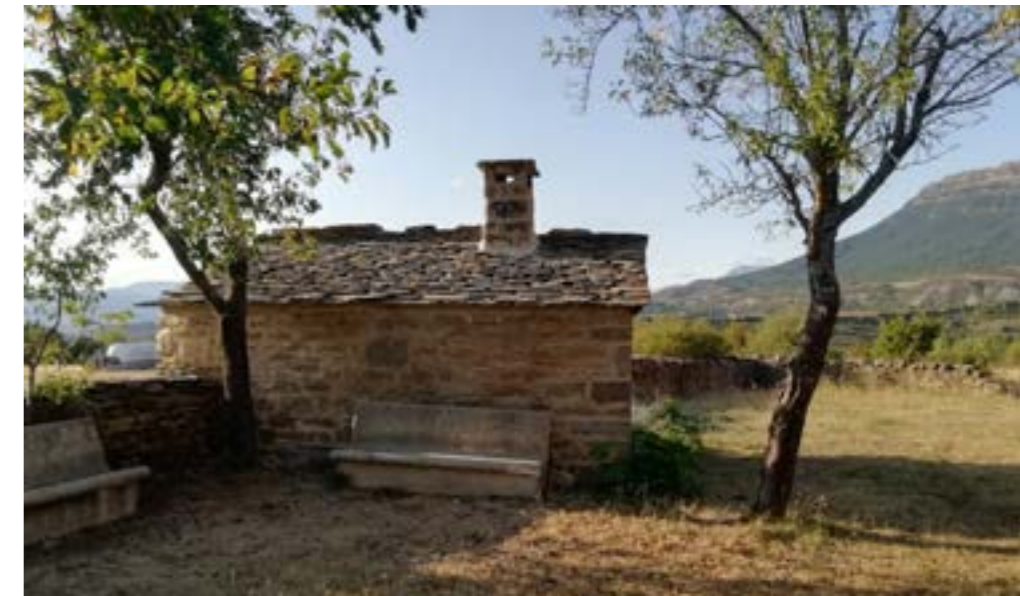
Bakehouse with its roof restored | Horno de pan, con la cubierta restaurada | Forno de pão, com a cobertura restaurada
