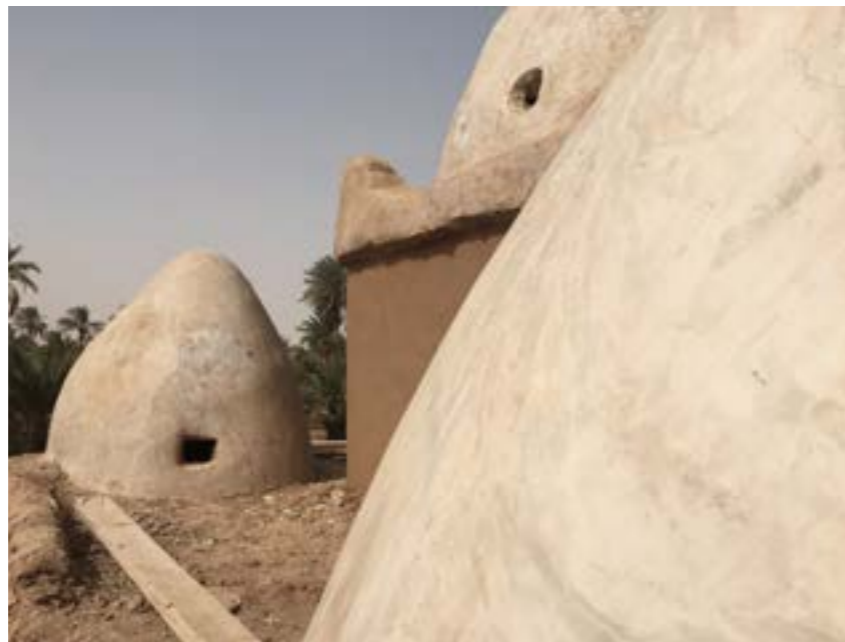
Exterior of the restored domes | Exterior de las cúpulas restauradas | Exterior das cúpulas restauradas
