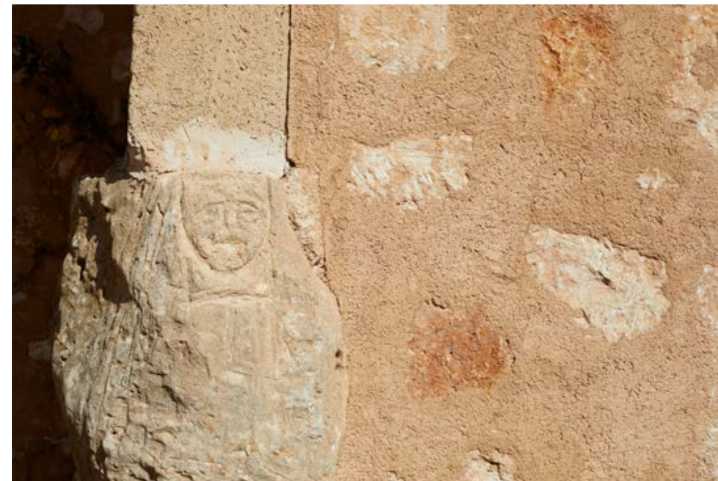
Detail of carved stonework | Detalle de una pieza de cantería labrada | Pormenor de uma peça de cantaria lavrada (Nando Esteva)
