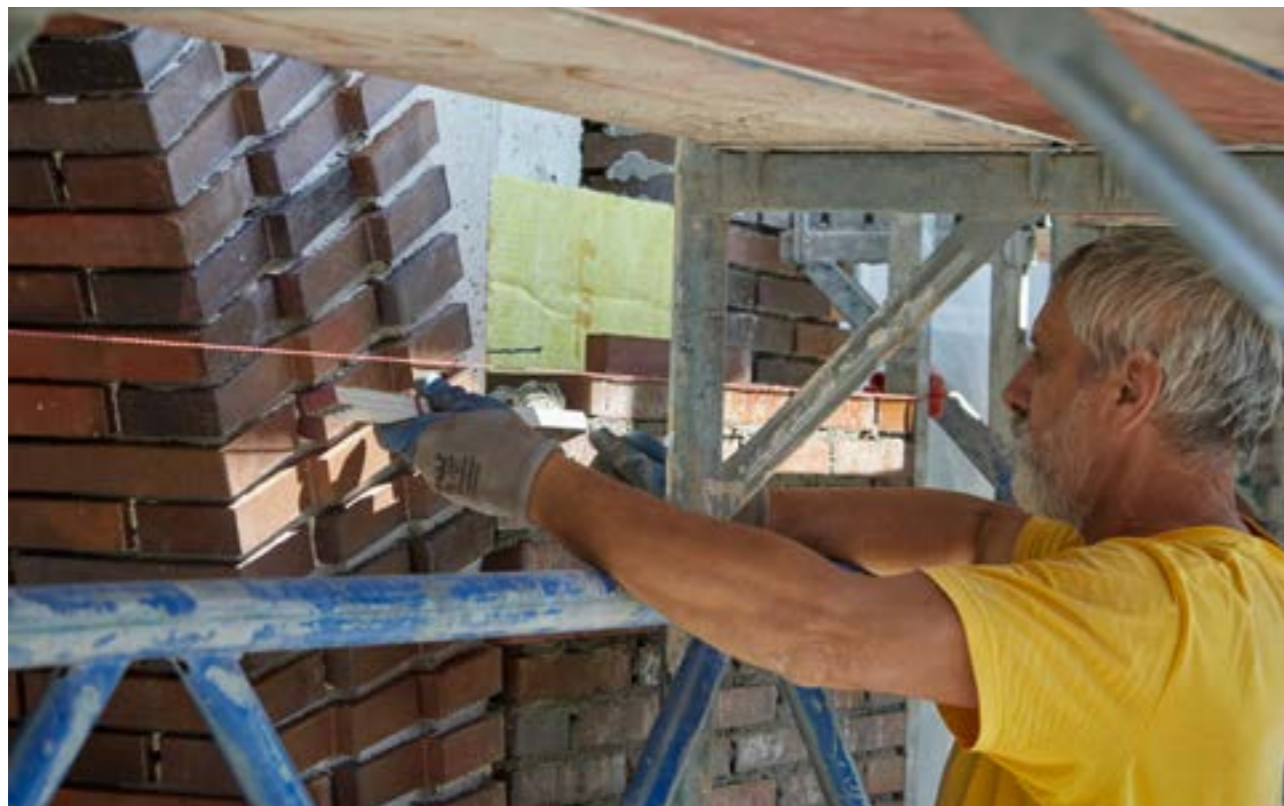
Bricklaying on site | Trabajo del ladrillo en obra | Trabalho do tijolo na obra (Andreas Gehrke)
