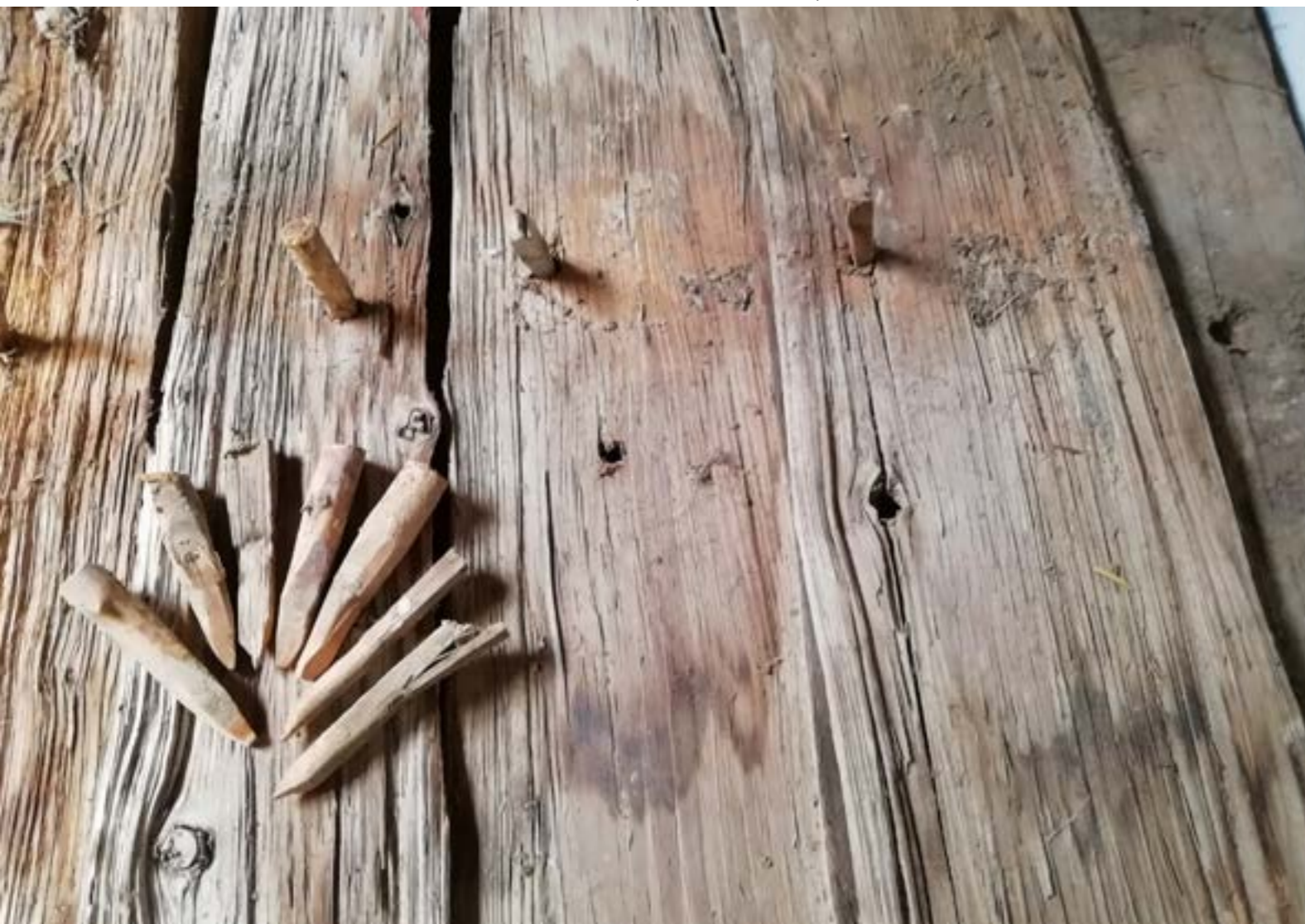
Pine rechas and pegs | Rechas y clavijas de pino | Rechas e cavilhas de pinheiro
