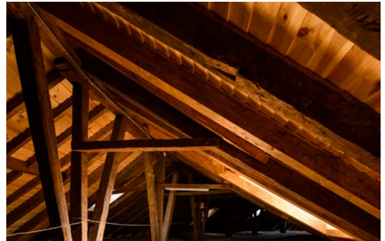
Restored roof structure | Estructura de cubierta restaurada | Estrutura da cobertura restaurada (Joaquín Zamora)
