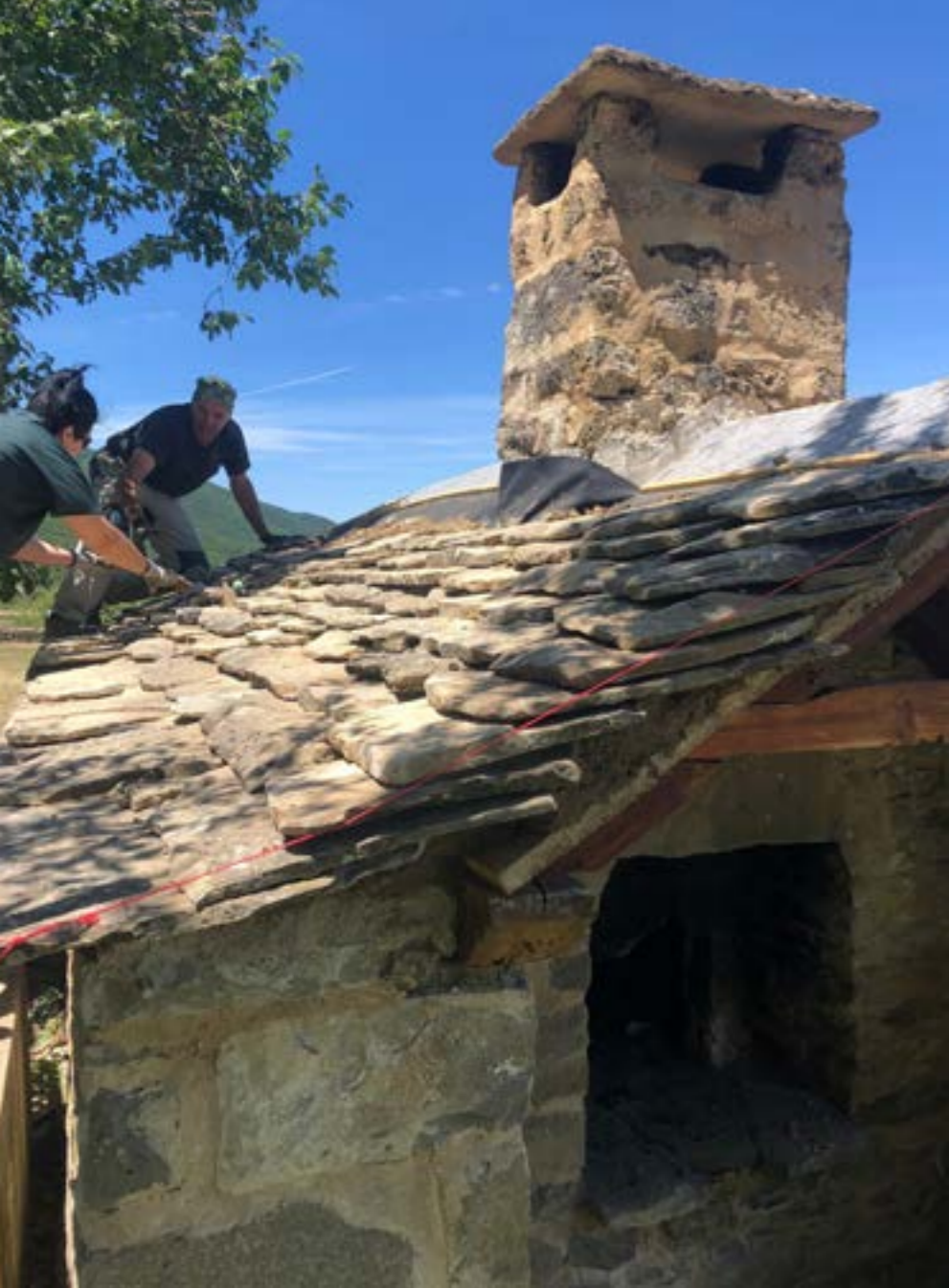
Laying of slabs | Colocación de las losas | Colocação das lajes
