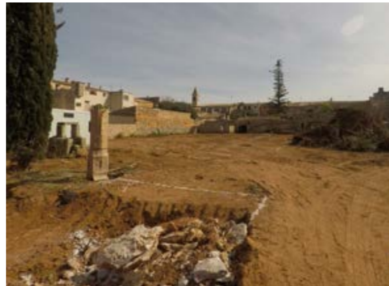
Previous state of the plot and staking out at the start of building work | Estado previo de la parcela y replanteos al comienzo de las obras | Estado prévio da parcela e traçados no início das obras
