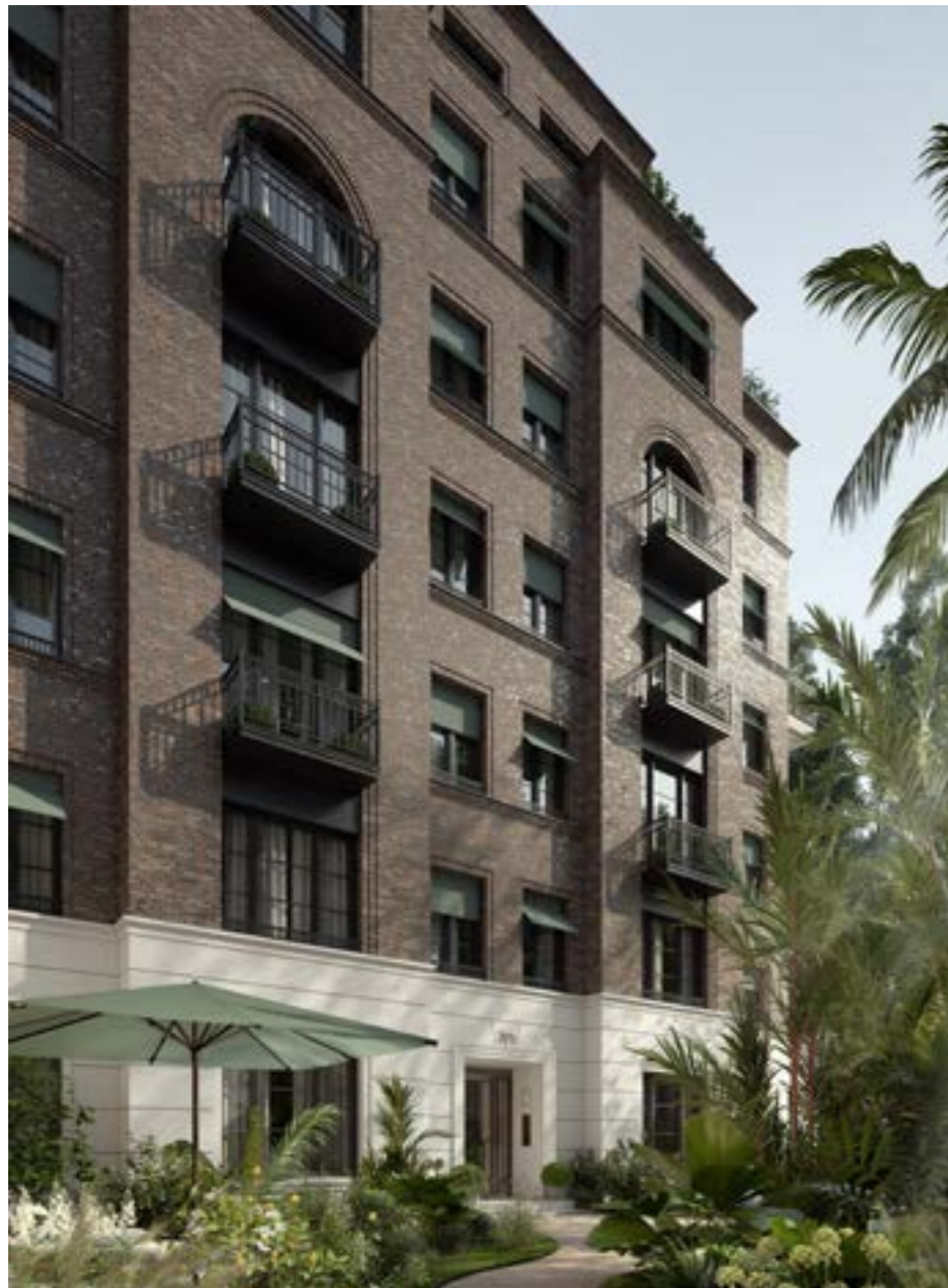
View of the building's courtyard façade | Vista de la fachada del edificio hacia el patio | Vista da fachada do pátio do edifício
