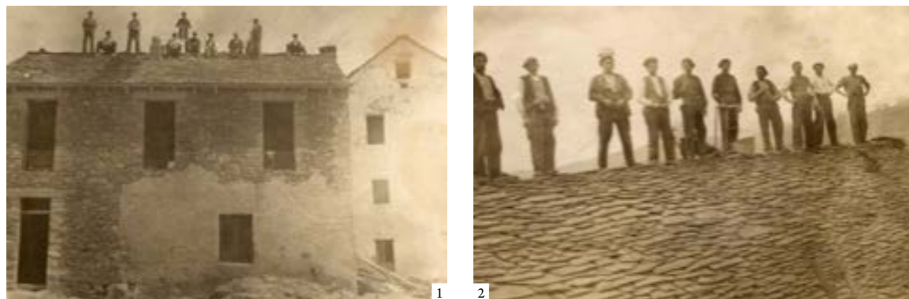
1: Building of a house in Sabiánigo, 1934 2: Building of a house in Sabiánigo, 1934. Detalle de the finished roof with the piqueros | 1: Casa en construcción en Sabiánigo, año 1934 2: Casa en construcción en Sabiánigo, año 1934. Detalle de la cubierta terminada y de los piqueros | 1: Casa em construção Sabiánigo, ano 1934 2: Casa em construção em Sabiánigo, ano 1934. Pormenor da cobertura terminada e dos piqueros (Family archive of Rosa Pueyo)
