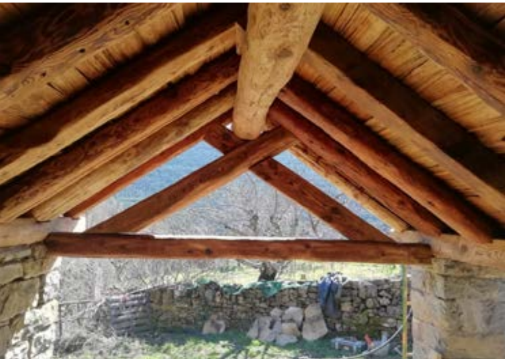
Roof structure from inside | Detalle interior de la estructura de la cubierta | Pormenor interior da estrutura da cobertura
