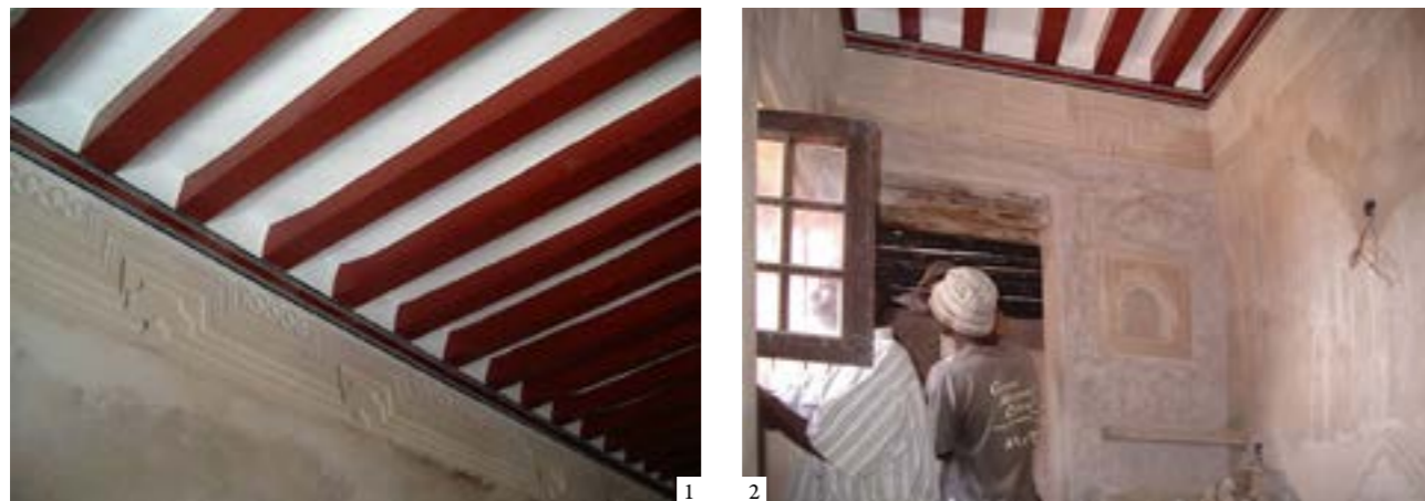
Floor structures with wooden beams and cornice decoration | Forjados con vigas de madera y cornisas decoradas | Estrutura com vigas de madeira e cornijas decoradas
