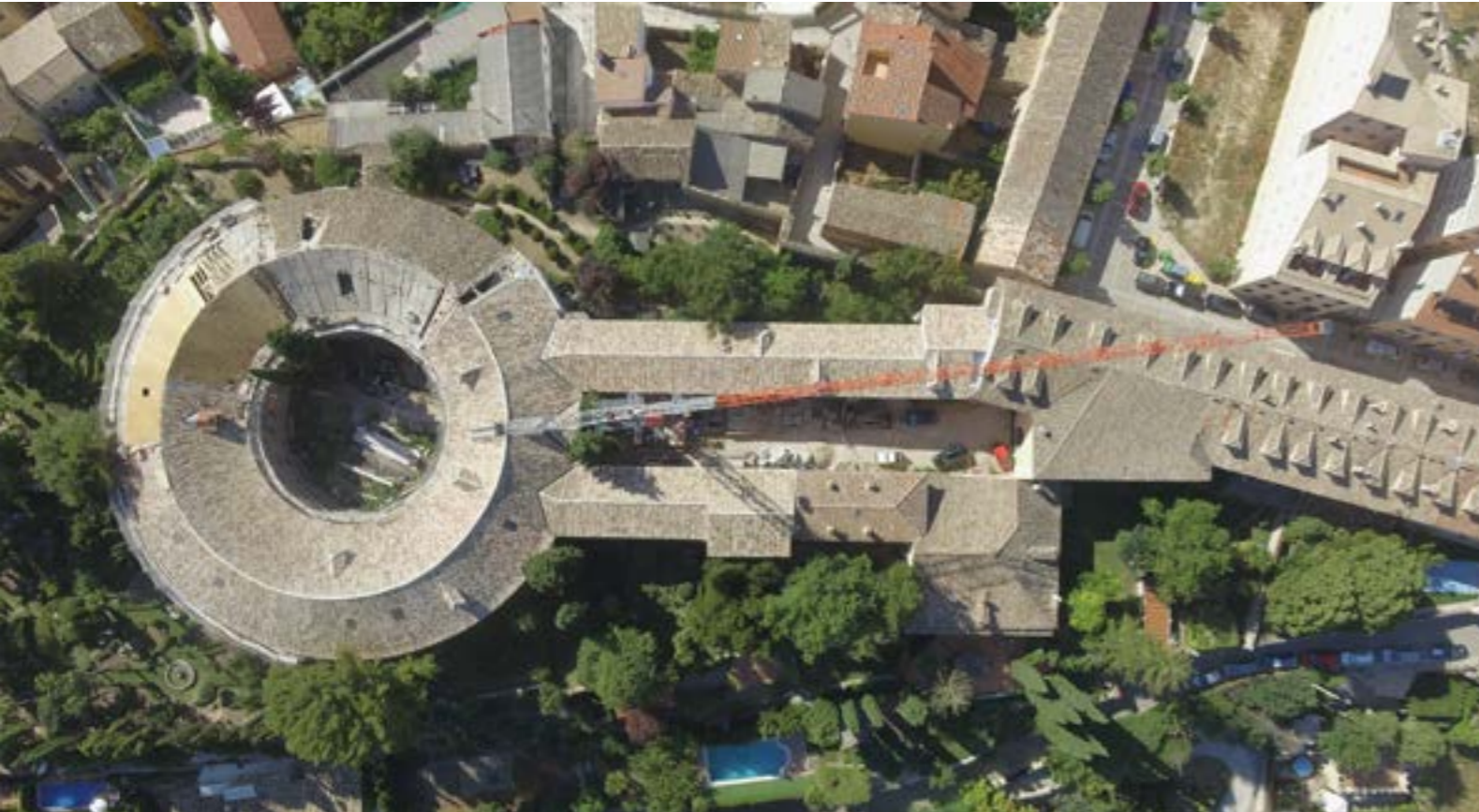
Aerial view of the Cloth Factory during the restoration works of the main building roofs | Imagen aérea de la Fábrica de Paños durante las obras de restauración de las cubiertas del edificio principal | Imagem aérea da Fábrica de Paños durante as obras de restauração das coberturas do edifício principal (Luis Fernando Abril)
