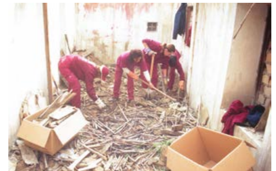
Thorough collection of the wood remains found in Carmen de las Palmas | Recogida minuciosa de los restos de madera encontrados en el Carmen de las Palmas | Recolha minuciosa dos restos de madeira encontrados no Carmen de las Palmas
