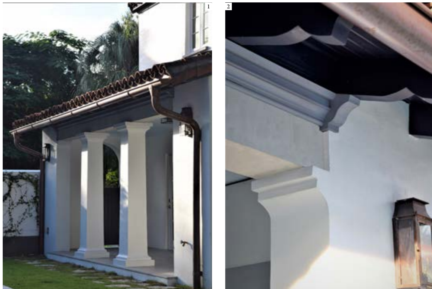
1: Carriage House Porch 2: Beam Detail & Eave at Carriage House Porch | 1: Porche de la cochera 2: Detalle de la viga y alero del porche de la cochera | 1: Alpendre da casa das carruagens 2: Detalhe da viga e do beiral do alpendre da casa das carruagens (Peter Kiliddjian)
