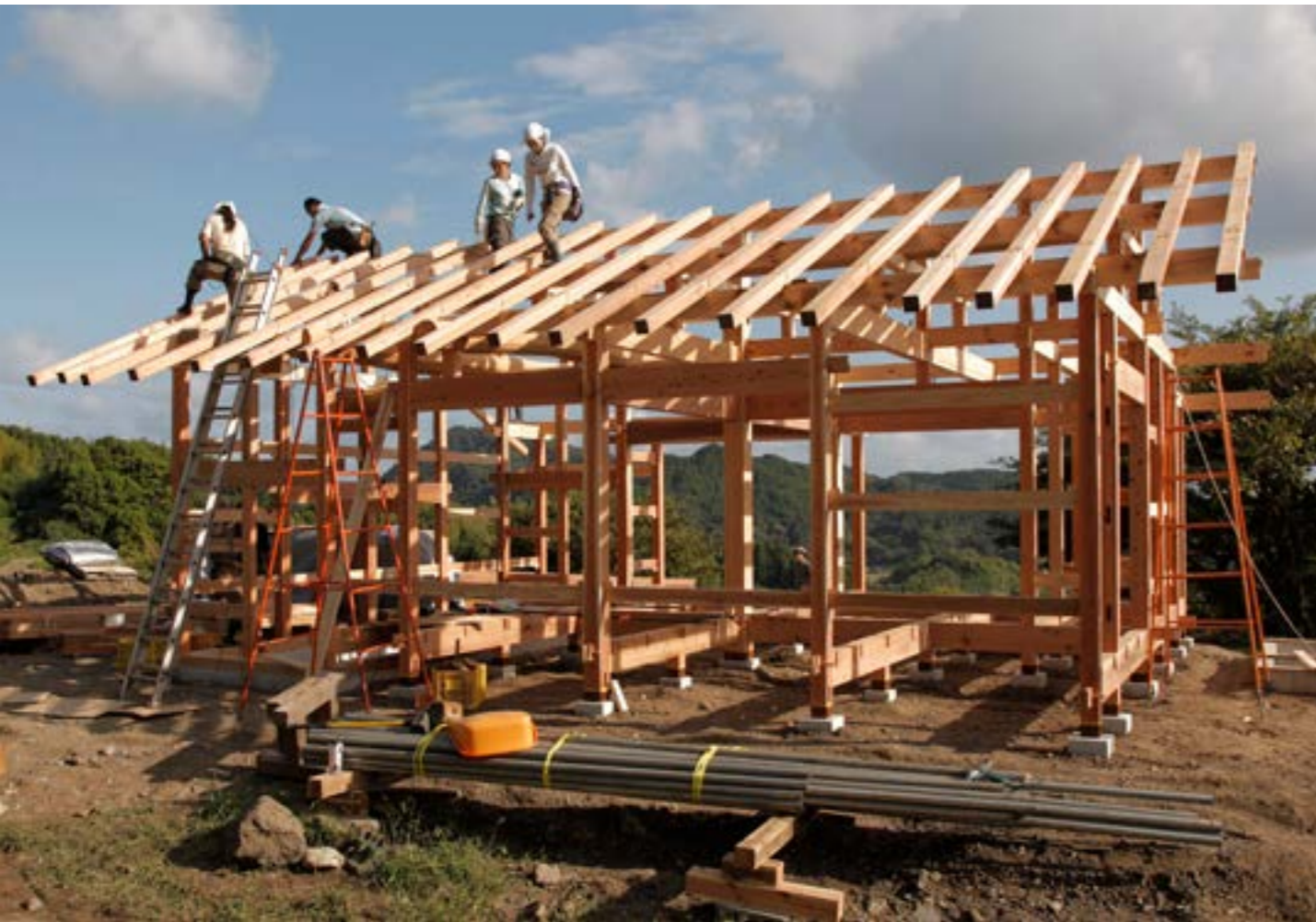
Assembly of rafters on the Kamogawa House | Montaje de pares en la Casa Kamogawa | Montagem dos caibros na Casa Kamogawa (Ken Kusakari)
