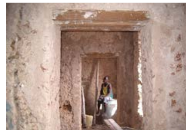
Building of Selas House | Construcción de la Casa Selas | Construção da Casa Selas
