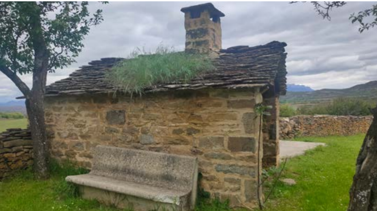
Roof of the bakehouse | Cubierta del horno de pan | Cobertura do forno do pão
