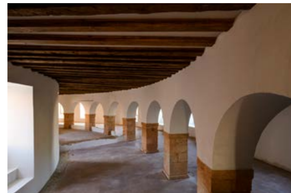
1: Pilasters of the arcades buried under the rubble; state before the second phase 2: Ground floor arcade with its actual scale after restoration works | 1: Pilastras de las arcadas enterradas bajo escombros: estado previo a la segunda fase 2: Arcada de planta baja con su escala real tras las obras de restauración | 1: Pilastras das arcadas enterradas sob os escombros: estado antes da segunda fase 2: Arcadas da planta térrea à escala real após as obras de restauração (Joaquín Zamora)
