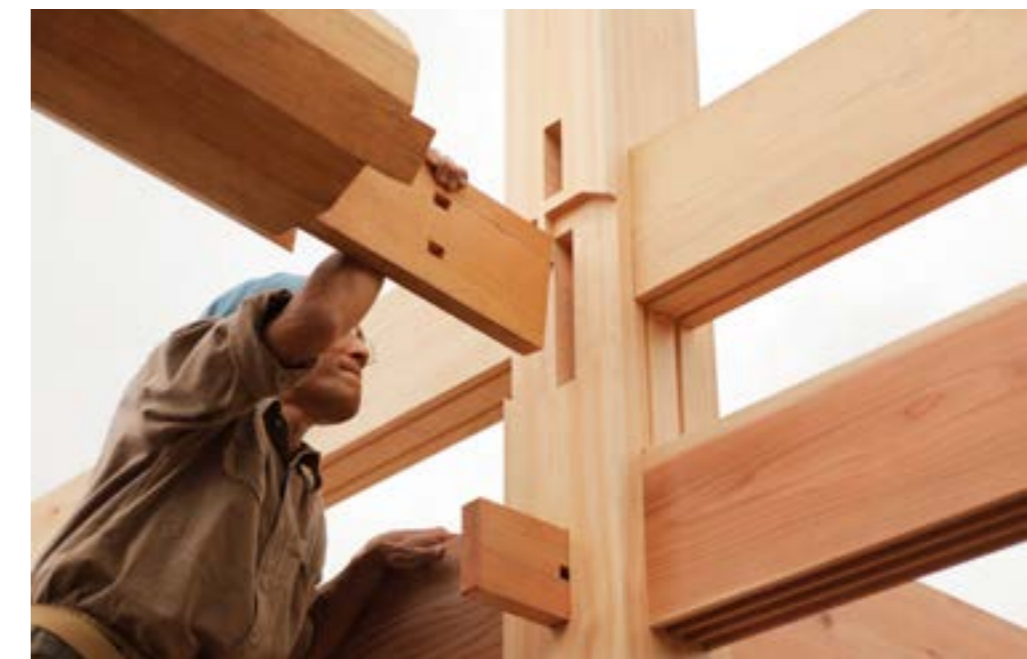
Erection of the framework of the Kamogawa House | Construcción del entramado de la Casa Kamogawa | Montagem da armação da Casa Kamogawa (Ken Kusakari)
