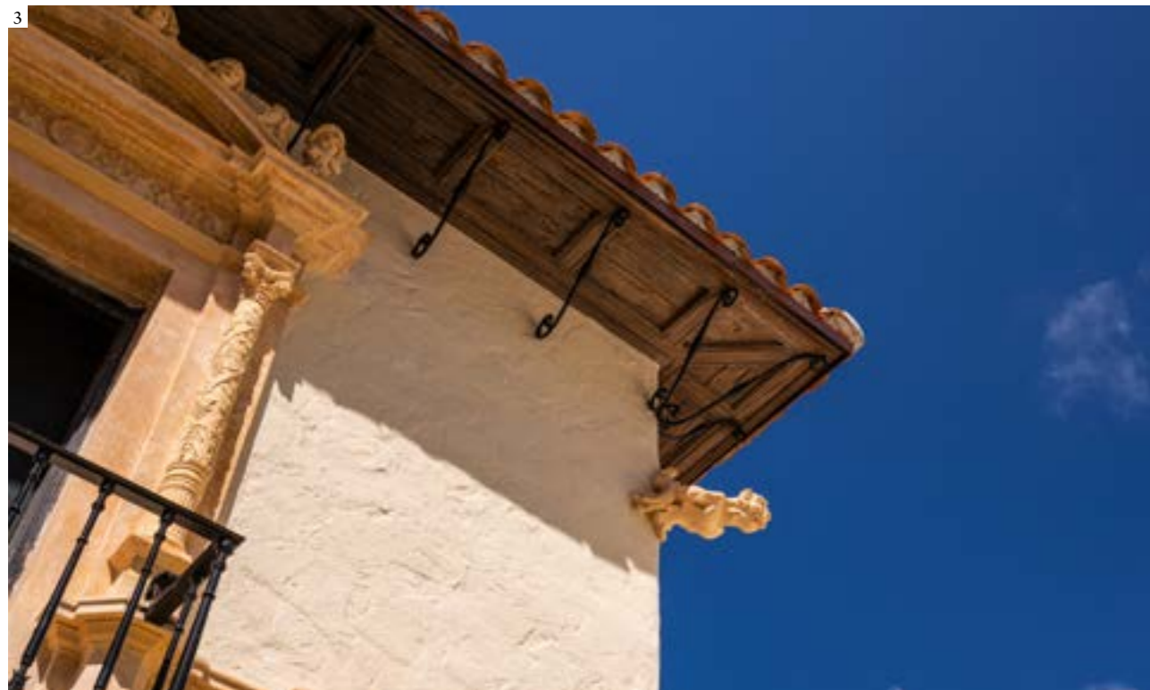
1, 2: Images of the gargoyle fragments. 3: Eave with a reconstructed gargoyle | 1, 2: Imágenes de los fragmentos de la gárgola. 3: Alero con una gárgola reconstruida | 1, 2: Imagens dos fragmentos da gárgola. 3: Beiral com uma gárgola reconstruída (3: Alex Tarajano)
