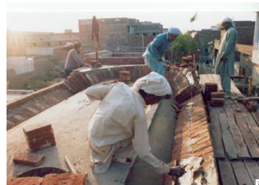
1: Building a flat dome with falsework. 2: Detail of brickwork | 1: Construcción de una bóveda plana con cimbra 2: Detalle de la fábrica de ladrillo | 1: Construção de uma cúpula plana com cimbres 2: Detalhe da alvenaria
