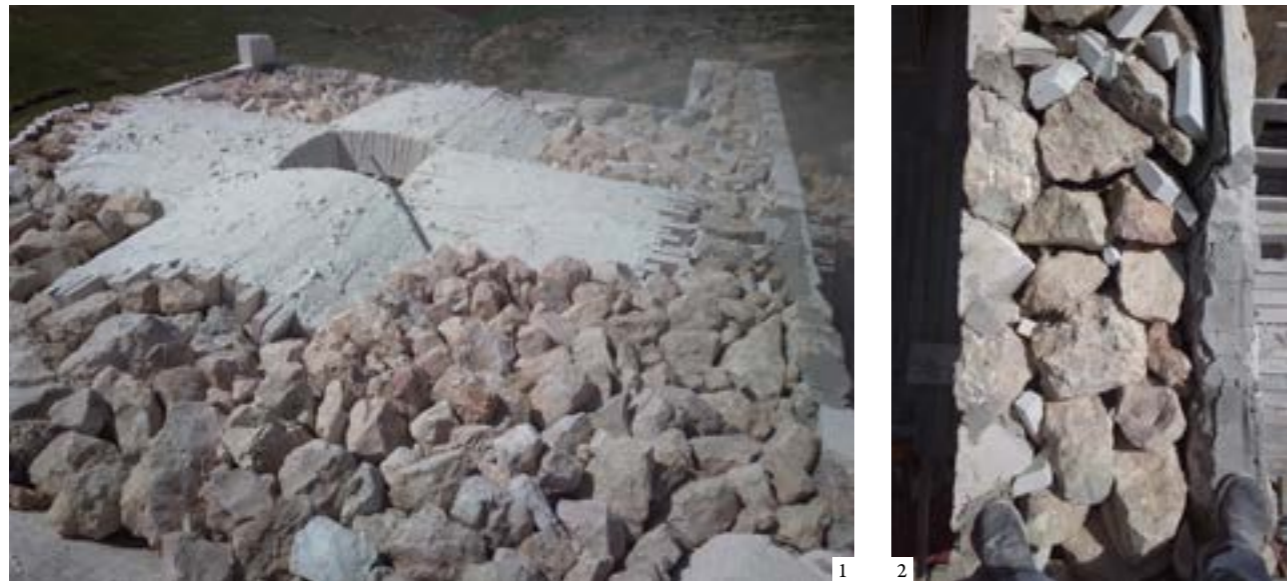
1: Construction of the loggia ceiling. 2: 75 cm stone wall filling. 3: Intersected vaulting over the kitchen. 4: Keystone at the intersection | 1: Construcción de la cubierta de la loggia. 2: Relleno del muro de 75 cm. 3: Intersección de bóvedas sobre la cocina. 4: Clave en la intersección | 1: Construção do teto da lóggia. 2: Preenchimento de pedra da parede com 75 cm. 3: Interseção das abóbadas sobre a cozinha. 4: Pedra angular na interseção
