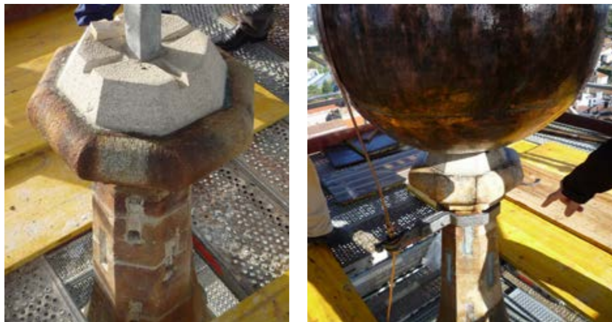
Colocación del vástago interno de un pináculo para fijar sobre él una bola
