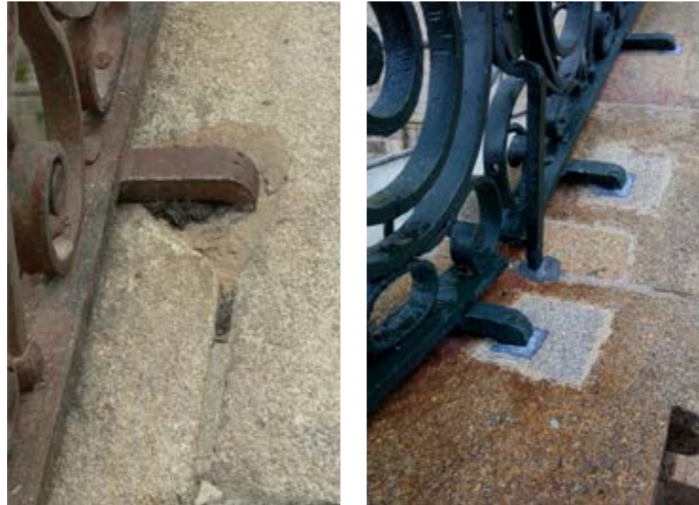
Estado previo y posterior a la restauración de una mala fijación de una reja a una losa de piedra
