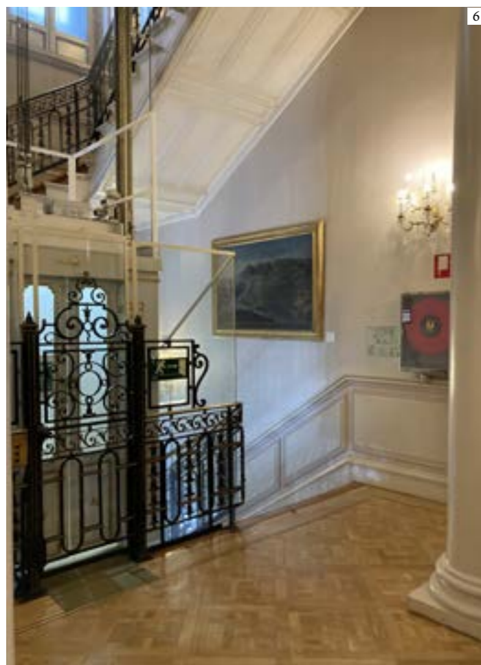
Figura 6: Escalera principal del Palacio de Villamejor, Madrid. Todos los paramentos y relieves están pintados con pinturas plásticas realizadas los mismos tonos (Luis Prieto)
