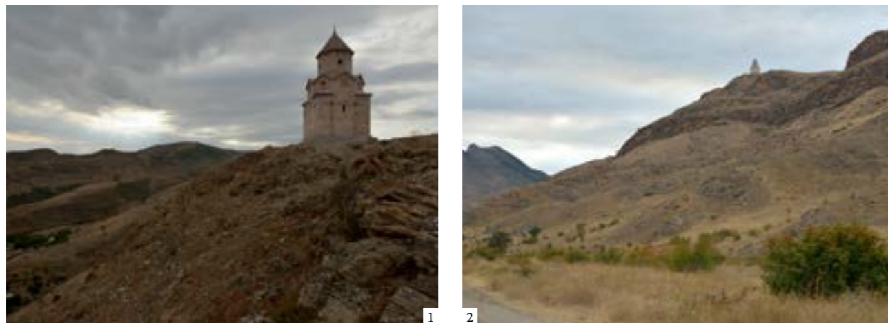
1, 2: Views of the Church from different points | 1, 2: Vistas de la Iglesia desde distintos puntos | 1, 2: Vistas da Igreja de diferentes pontos
