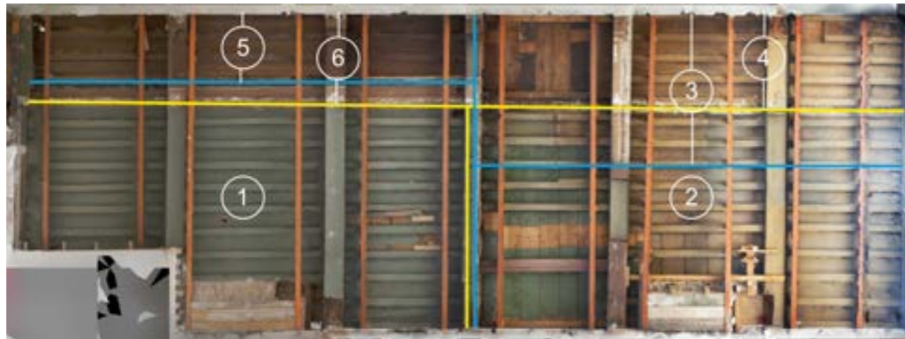
Ceiling during demolition with construction traces and results of historical paint research by J. Tegelaar. Blue: original floor plan, ca. 1620. Yellow: adjusted floor plan, eighteenth century | Techo durante la demolición con restos de construcción y resultados del estudio de pintura histórica de J. Tegelaar. Azul: planta original, ca. 1620. Amarillo: planta adaptada, siglo XVIII | Teto durante a demolição, com vestígios de construção e resultados da pesquisa histórica da pintura, por J. Tegelaar. Azul: planta original, ca. 1620. Amarelo: planta ajustada, século XVIII (by author, on photogrammetry by D. Derksen, Monumenten en Archeologie Municipality of Amsterdam)
