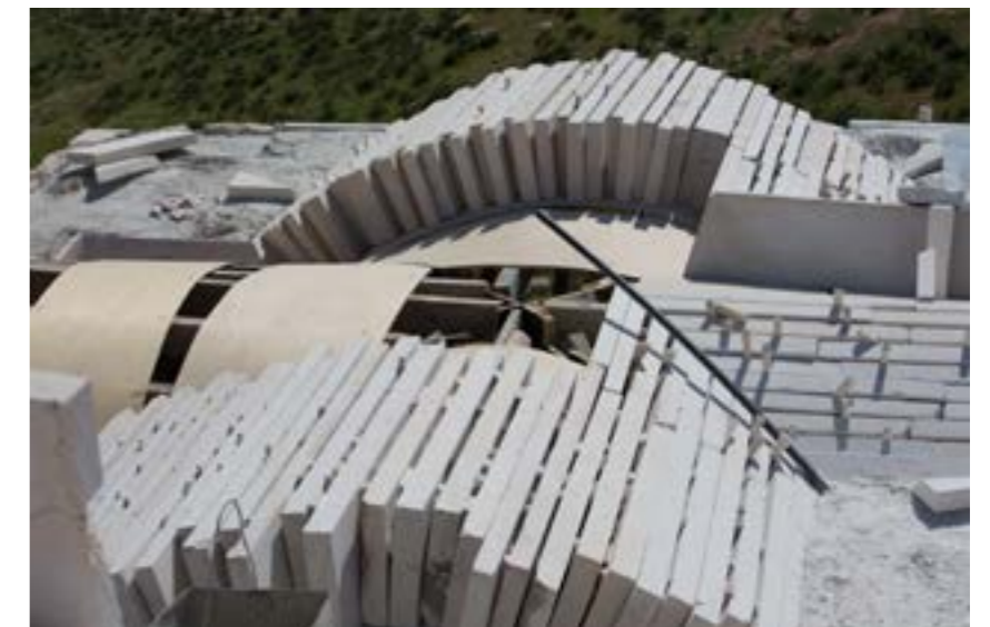
Construction of a groin vault in the loggia | Construcción de una bóveda de arista en la loggia | Construção de uma abóbada de aresta na loggia
