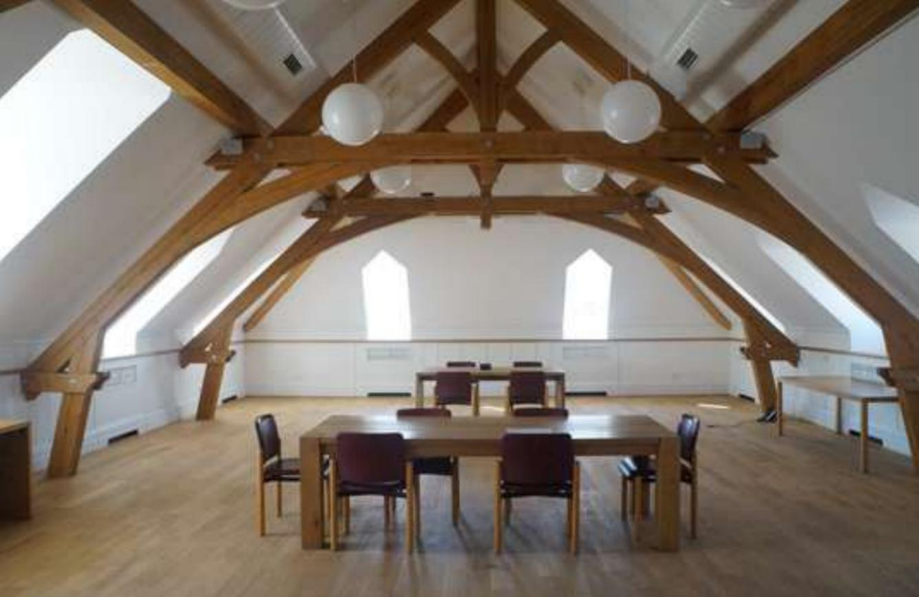
Oaken roof structure | Estructura de roble del tejado | Estrutura do telhado em madeira de carvalho
