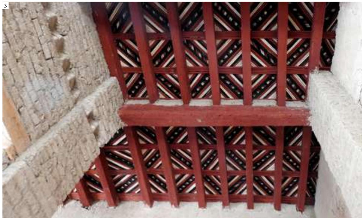
1: Adobe staircase to the second floor 2: Second-floor interior 3: Café ceiling with wood of three colors stained in a boiling pot | 1: Escalera de adobe que sube a la segunda planta 2: Interior de la segunda planta 3: Techo de la cafetería con las maderas teñidas en caldero en tres colores | 1: Escada em adobe que sobe até ao segundo andar 2: Interior do segundo andar 3: Teto do café com madeiras tingidas em três cores num caldeirão (1, 2: Manuel Blanc)
