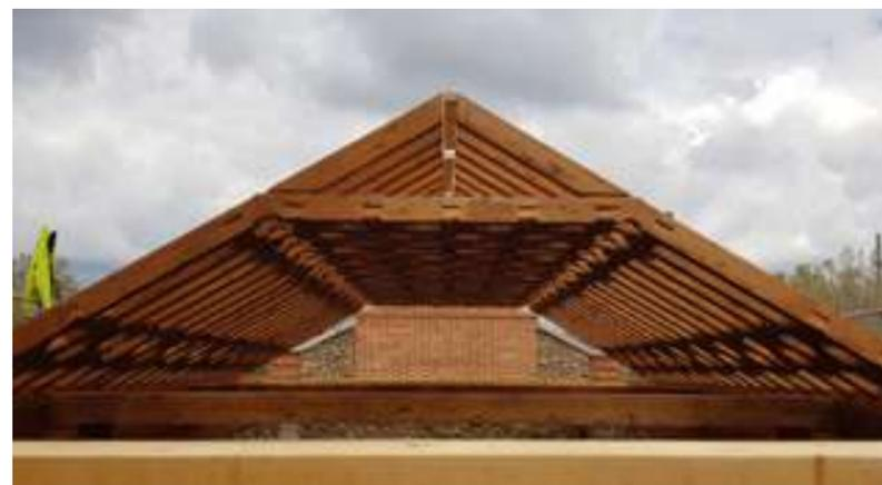
Front view of the collar-beam roof structure | Vista frontal de la armadura de par y nudillo de la ermita | Vista frontal da armação de par y nudillo da ermita
