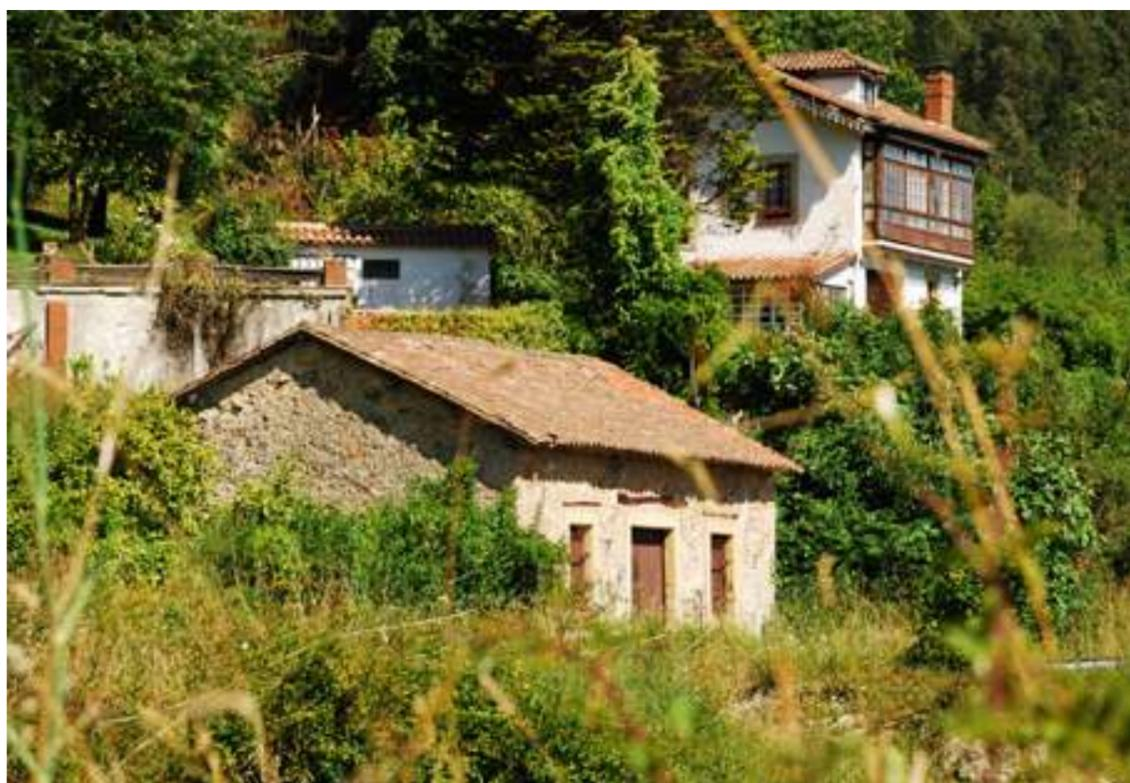
Figura 2: Llagar arquetípico construido contra el terreno y situado junto a una vía de comunicación. Construido en piedra y madera, su fachada principal presenta la composición más común en los llagares tradicionales: portalón central de madera y dos ventanas simétricas a los lados con contraventanas que se abren desde y hacia el interior.
