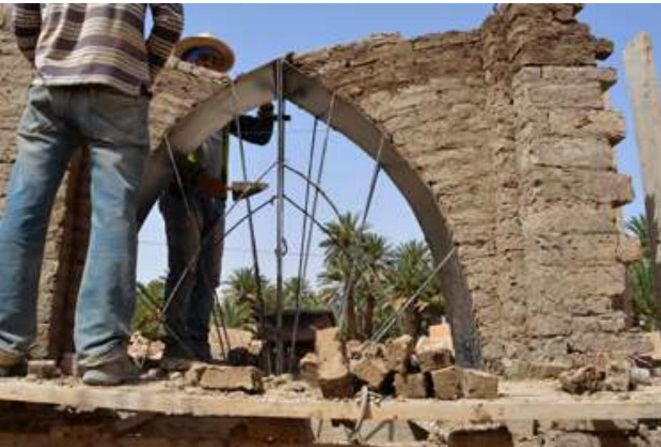
Construction of adobe arches with metal formwork, and of rammed-earth walls | Construcción de arcos de adobe con cimbras metálicas y construcción de muros con tapial | Construção de arcos de adobe com cimbre metálico e construção de paredes de taipa
