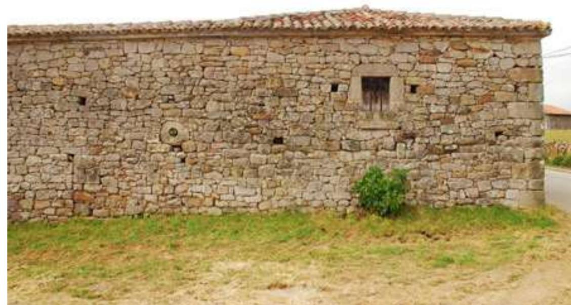
Figura 4: *Llagar* de Tano, cuyos paramentos verticales están contruidos con mampostería irregular (posiblemente reaprovechada) y con sillares en las cadenas esquineras y en los cercos de los huecos.
