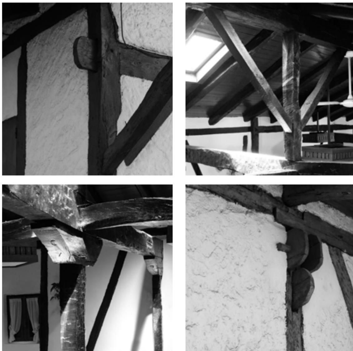
Figura 11: Detalles de la estructura de madera. (01) Ángulo entre la fachada principal y lateral, (02) Montante y puntales de la cubrera, (03) Apoyo de los postes con zapata, (04) Unión en espiga entre las vigas y los montantes de la fachada lateral.
