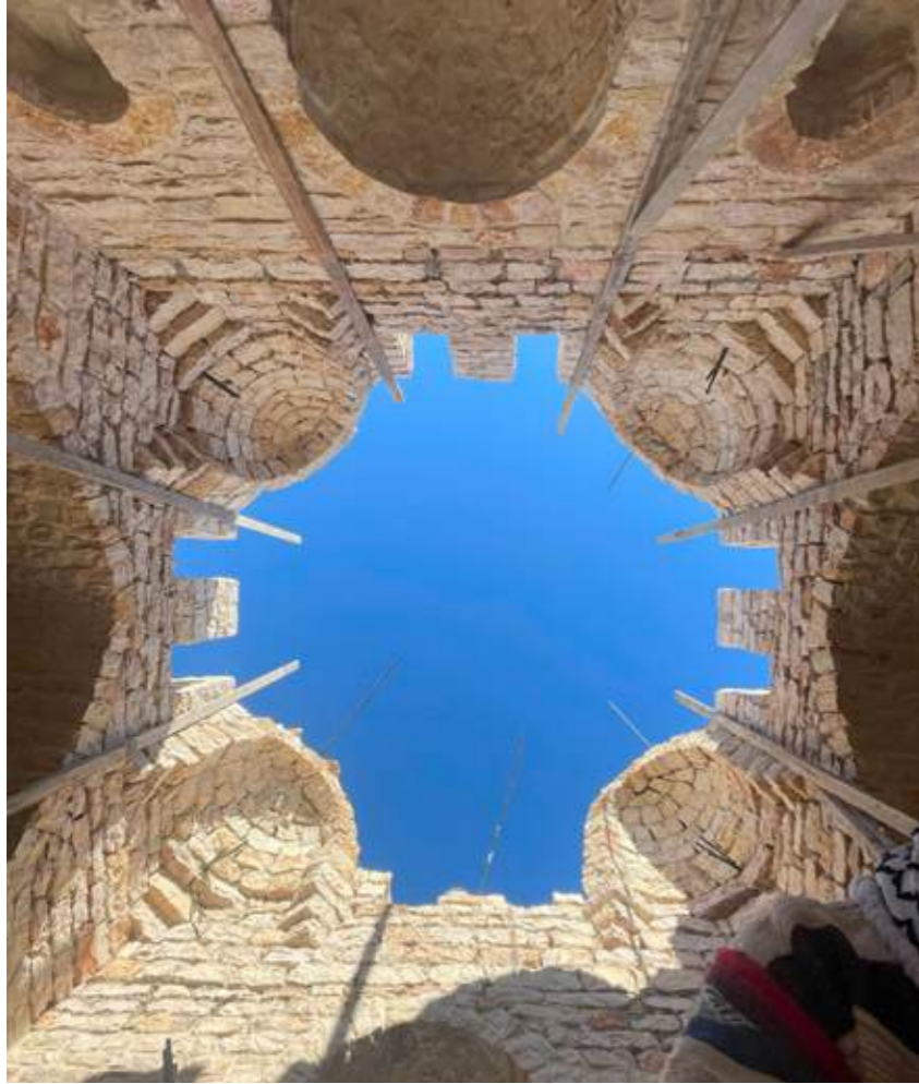
The four squinches completed inside the main dome, with twin windows between them | Vista interior de la cúpula principal, con las cuatro trompas completadas y ventanas gemelas situadas entre ellas | Vista interior da cúpula principal, com quatro trompas concluídas e janelas duplas entre elas
