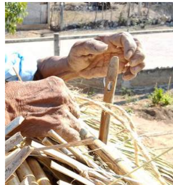
Figura 29: Aguja de otate para tejer los techos de hojas de caña o palma en Tonahuixtla, Puebla
