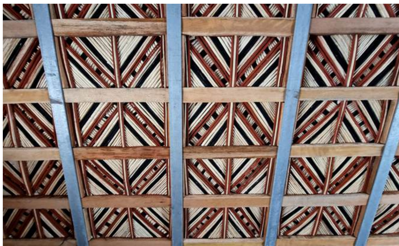
Traditional tataouis technique: laurel ceilings dyed red with iron pigment or black with soot in a cauldron, with a palm-wood structure | Técnica tradicional tataoui : techos de laurel teñidos de rojo con pigmento de hierro o de negro con hollín en un caldero, con una estructura de madera de palma | Técnica tradicional dos tataouis : tectos de louro tradicionais tingidos de vermelho (com pigmentos de ferro) ou de preto (com fuligem) num caldeirão, construído sobre uma estrutura de palmeira
