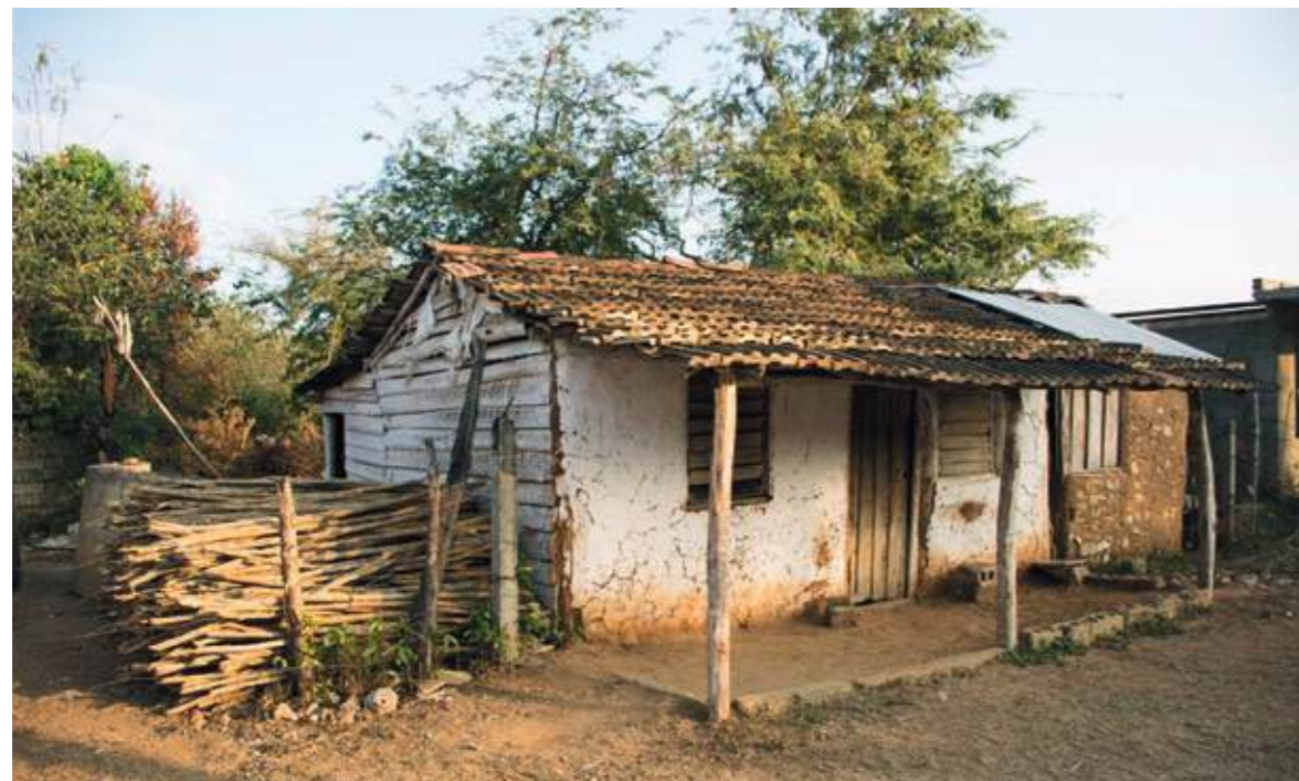
Figura 5: Vivienda construida con la técnica del "embarrado" en San Pedro, Cuba, 2022 (Alexis Rodríguez)
