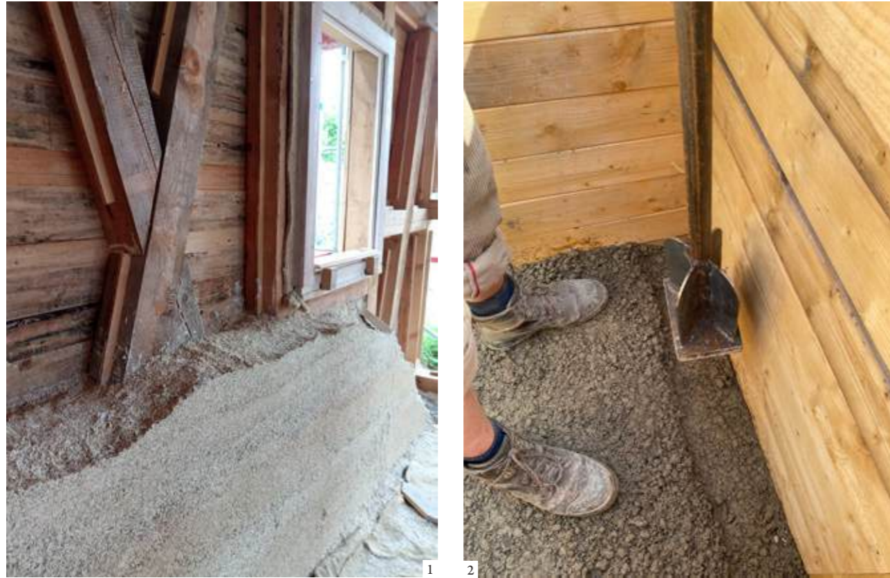
1: Hempcrete wall insulation 2: Roman concrete foundation | 1: Aislamiento de pared de hormigón de cáñamo 2: Cimientos de hormigón romano | 1: Isolamento de paredes com betão de cânhamo 2: Fundação romana em betão (1, 2: Geschichtspark Bärnau)
