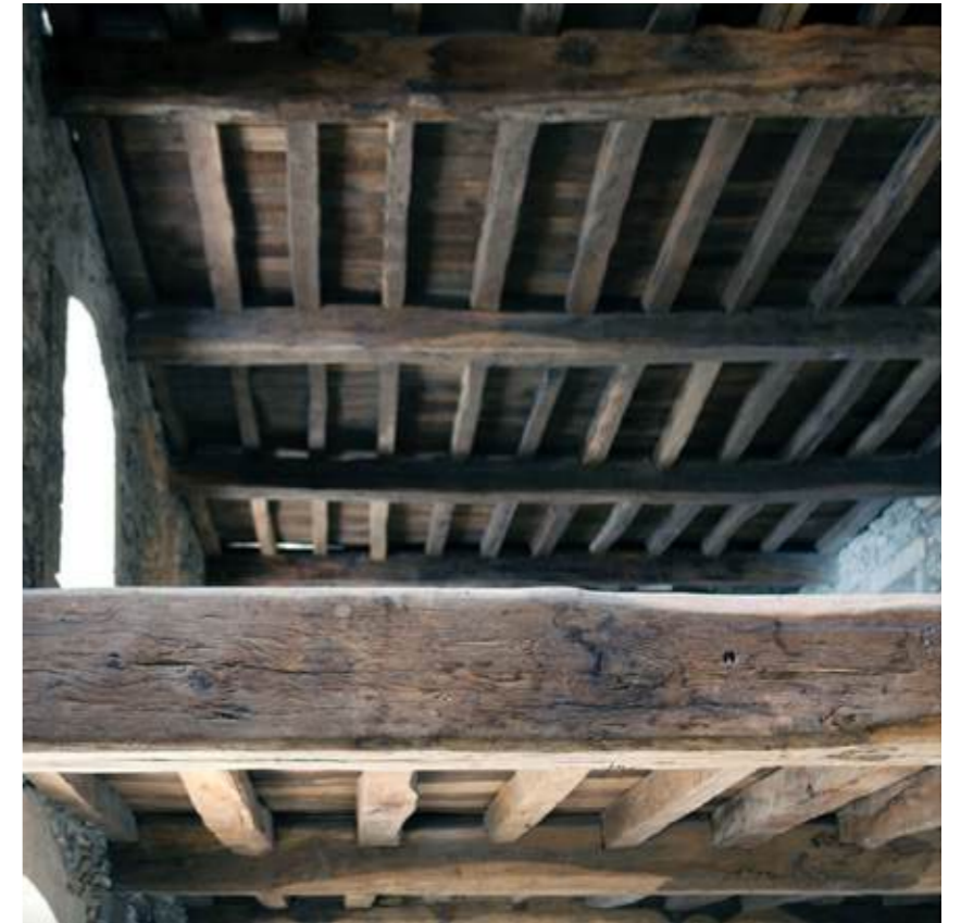
Structural woodwork | Estructura de madera | Estrutura de madeira
