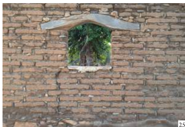
Figura 23: Entrada de una casa con muros de adobe y dintel de madera en la comunidad de Gabino Barreda, San Jerónimo Xayacatlán, Puebla
