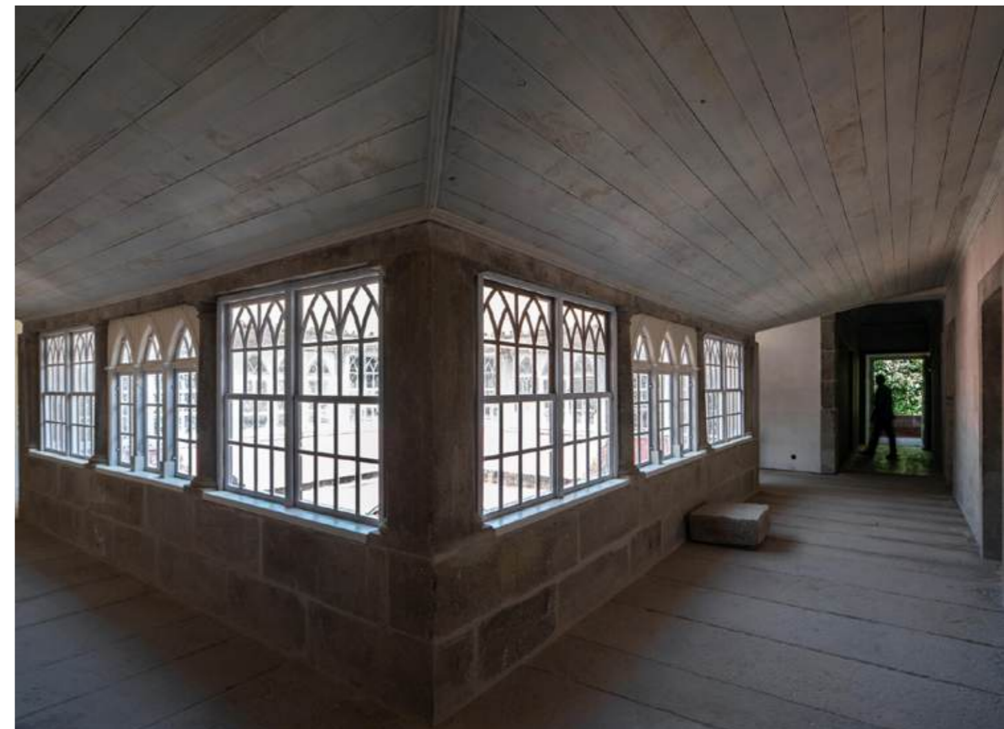
Cloister: upper floor after restoration of window frames and fitting of a new wooden roof | Claustro: planta superior después de la restauración de los marcos de las ventanas y la instalación de un nuevo techo de madera | Claustro: piso superior após a recuperação das caixilharias e a execução do novo tecto em madeira (Maria João Gala)
