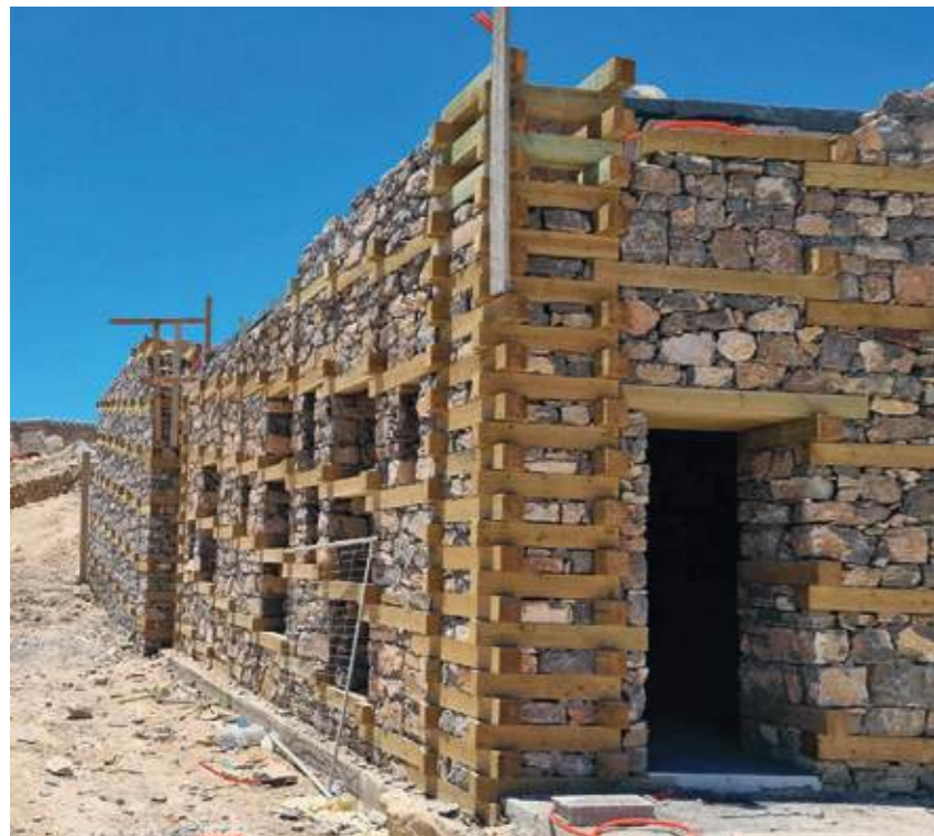
The earthquake-resistant dry-stone and timber system | Sistema sismorresistente construido con piedra seca y madera | Pormenor do sistema de pedra seca e madeira da Cidadela, resistente a terremotos
