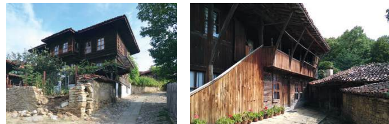
Figuras 4 y 5: Ejemplos de grandes aleros y porches: Casa Kyorpeev en Kotel y Casa Sava Filaretov en Zheravna
