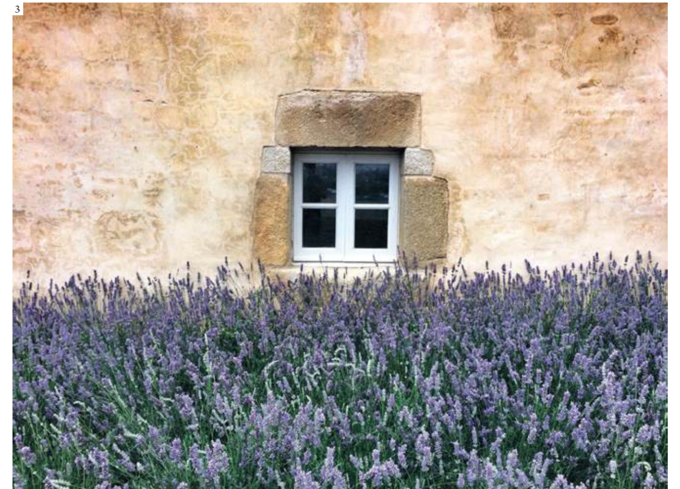
1: Selection of granite for borders. 2: Flooring set out in the workshop. b3: Lime render on the west facade | 1: Selección de la piedra de granito para los recercados. 2: Replanteo de suelo realizado en el taller. 3: Detalle de los revestimientos de cal de la fachada oeste | 1: Seleção da pedra de granito para as guarnições. 2: Preparação de implantação do pavimento, realizada na oficina 3: Pormenor do revestimento de cal na fachada oeste (1: Javier Ortega)
