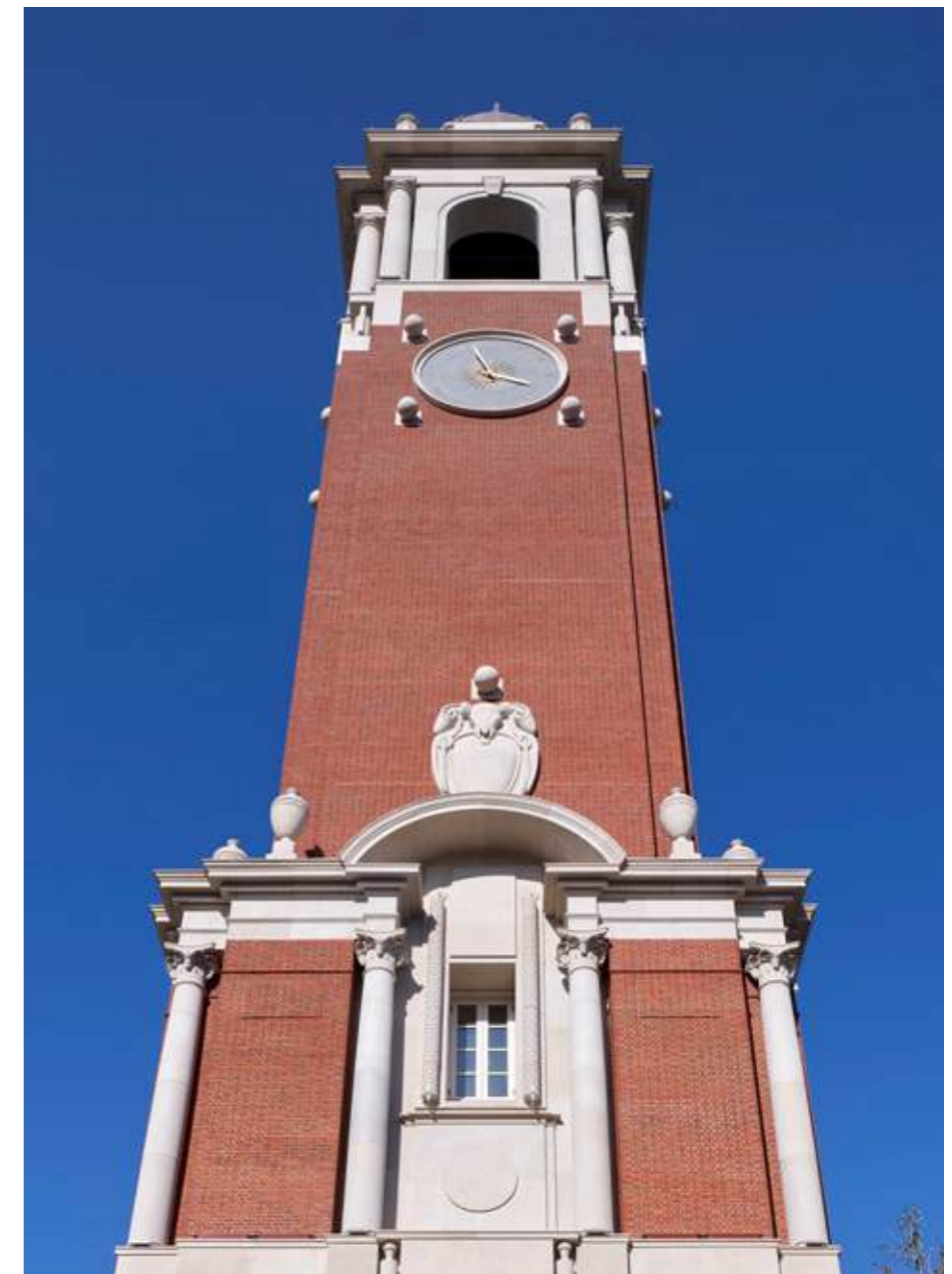
The upper portion of the Campanile | Parte superior del Campanile | A porção superior do Campanile (Paul Highnam)
