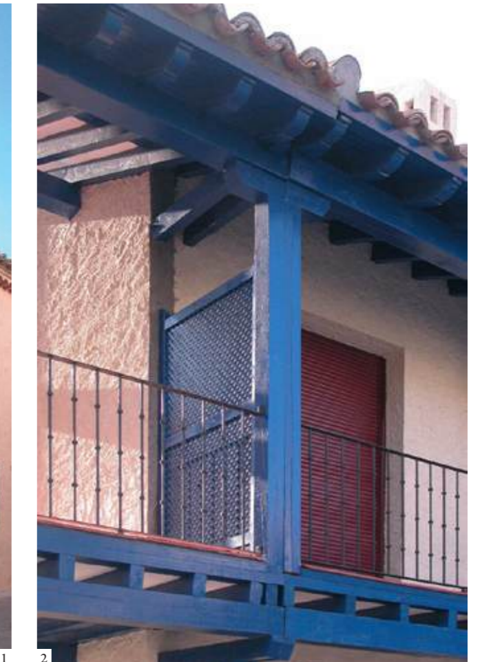
1: Balcony in the inner street 2: Detail of the continuous balcony over the square with separating elements | 1: Detalle de los balcones de la calle interior 2: Detalle de la balconada de la plaza con elementos de separación | 1: Detalhe das varandas da rua interior 2: Detalhe da varanda da praça com elementos de separação
