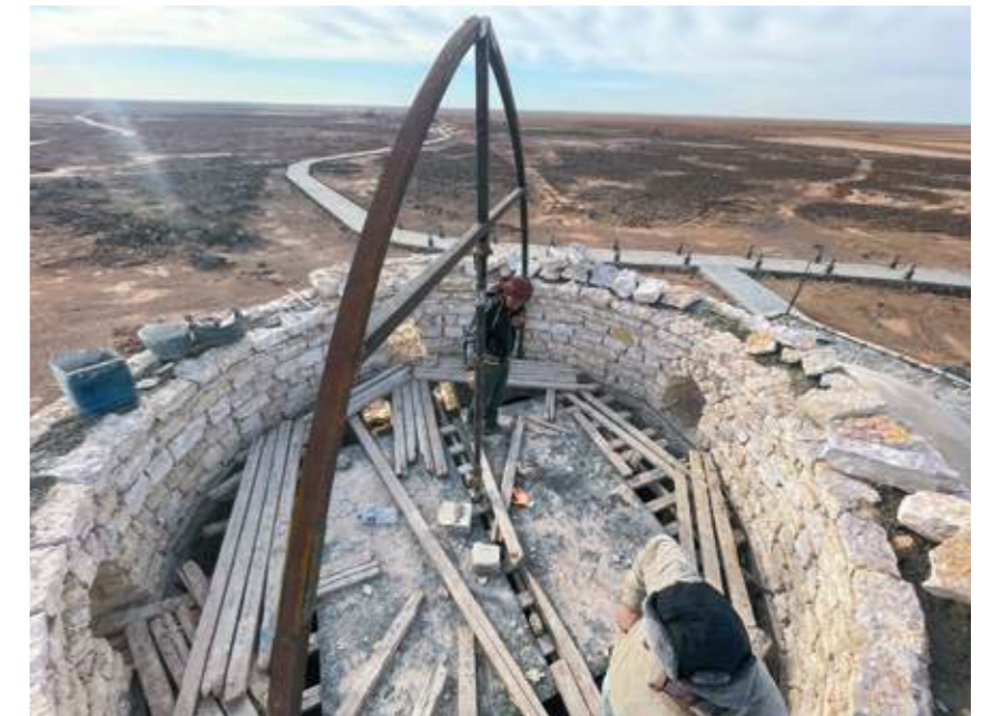
Center-supported, rotating metal arc for guiding the construction of the dome | Arco metálico giratorio apoyado en el centro que tiene por fin servir de guía durante la construcción de la cúpula | A guia metálica apoiada no centro, roda no eixo vertical, para orientar o construtor durante a construção da cúpula
