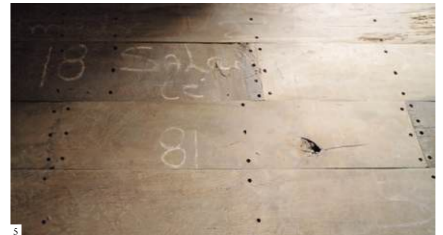
1: The palace's main stairs. 2: Detail of a door with rivets at the original tower entrance. 3: Detail of an original iron fitting. 4, 5: Laying of flooring | 1: Escalera principal del Palacio. 2: Detalle de una puerta con remaches, en la entrada original a la torre. 3: Detalle de un herraje original de puerta. 4, 5: Detalle de colocación de suelo | 1: Escadaria principal do Palácio. 2: Pormenor de uma porta com rebites, na entrada original da torre. 3: Pormenor dos ferragens originais de uma porta. 4, 5: Pormenor de assentamento do pavimento (1: Pablo Sevilla y Guillermo Gil)
