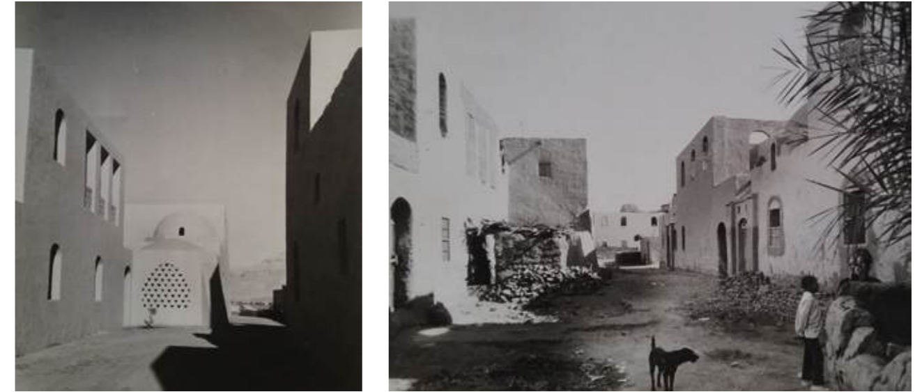
Figure 5: Before and after vandalism and misuse of buildings in New Gourna | Los edificios de Nueva Gourna antes y después del vandalismo y el uso indebido | Antes e depois do vandalismo e da má utilização dos edifícios em Nova Gourna
