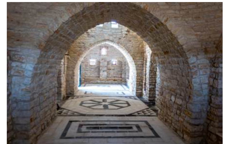
3/5 pointed vault with transition between the shallow dome and the main dome | Bóveda apuntada de 3/5 con transición entre la cúpula baja y la cúpula principal | Abóbada pontiaguda de 3/5. Zona de transição entre a cúpula baixa e a cúpula principal
