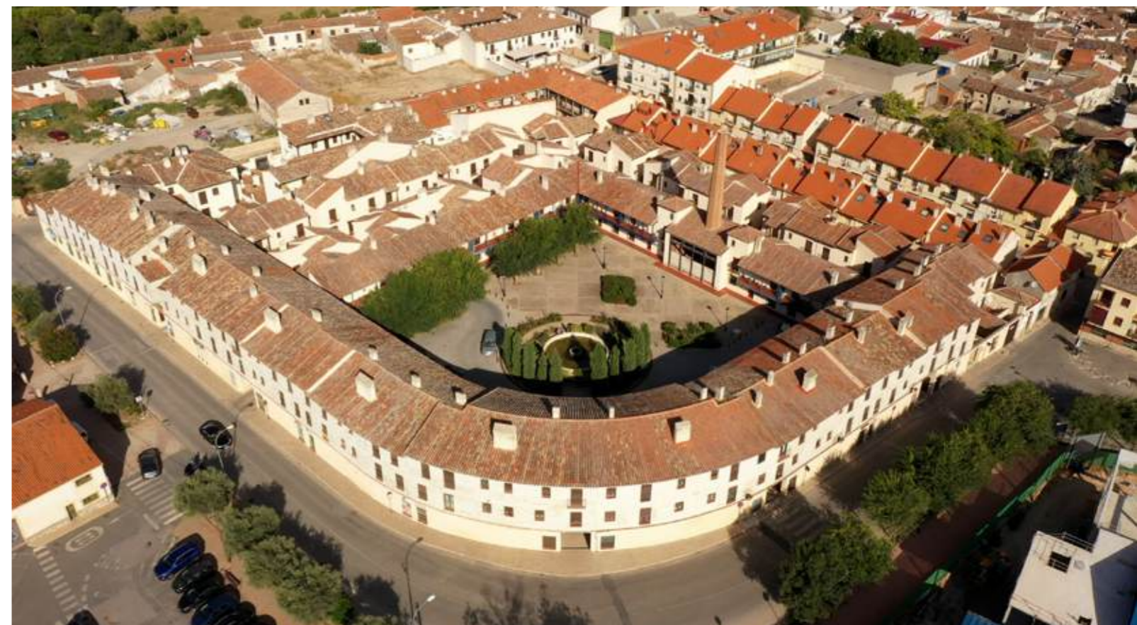
Aerial view of the residential complex in September 2024 | Fotografía aérea del conjunto residencial en septiembre de 2024 | Fotografia aérea do conjunto residencial em setembro de 2024 (Fundación Culturas Constructivas Tradicionales)
