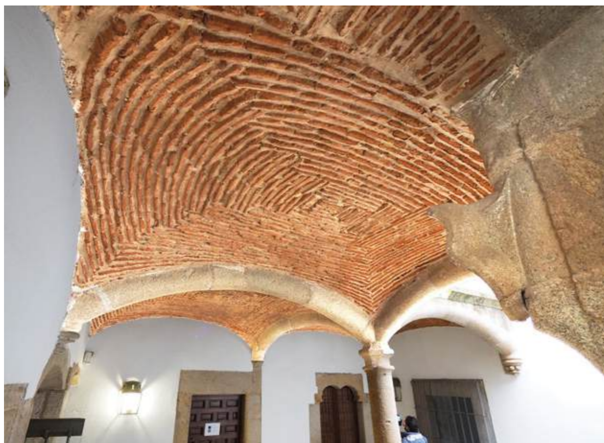
Figura 17. Bóveda en “tapa de coche” en la Casa del Mono, Cáceres
