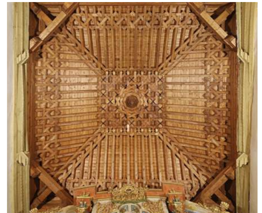
New roof structure over the chancel | Nueva armadura de cubierta del presbiterio | Nova estrutura do tecto do presbitério
