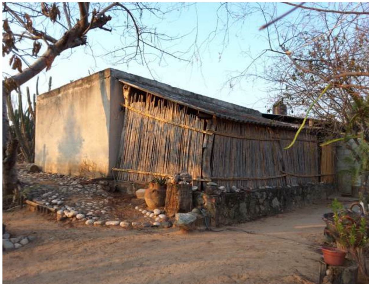
Figura 3: Arquitectura vernácula en Tonaixtla, Puebla: casa de adobe con corredor de chiname
