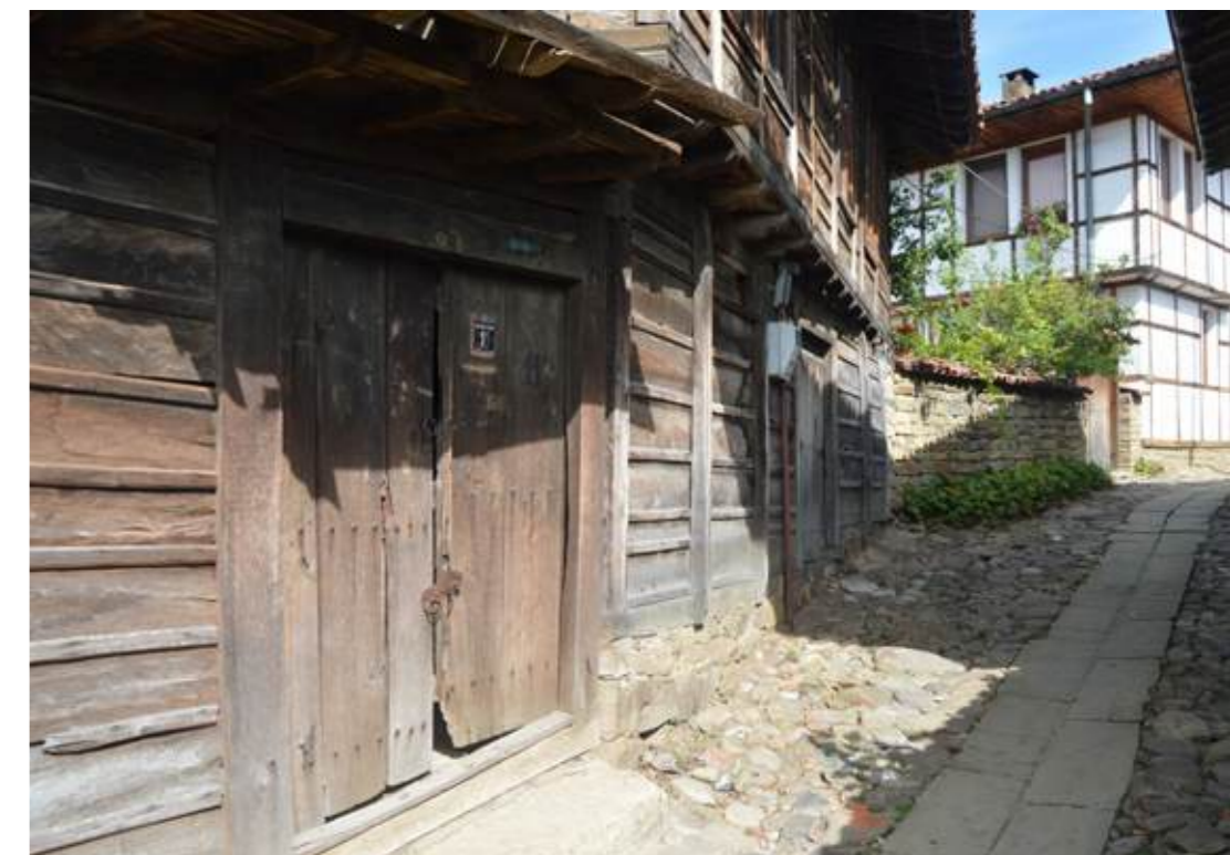
Figura 12: Característicos entramados de poste y tabla en las casas Kozichkovi
