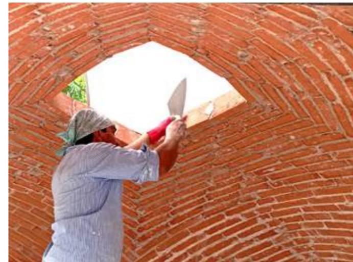
Figura 3. Bóveda de trompas o de esquinas, apoyada en un perímetro horizontal, realizada por el maestro Andrés Flores
