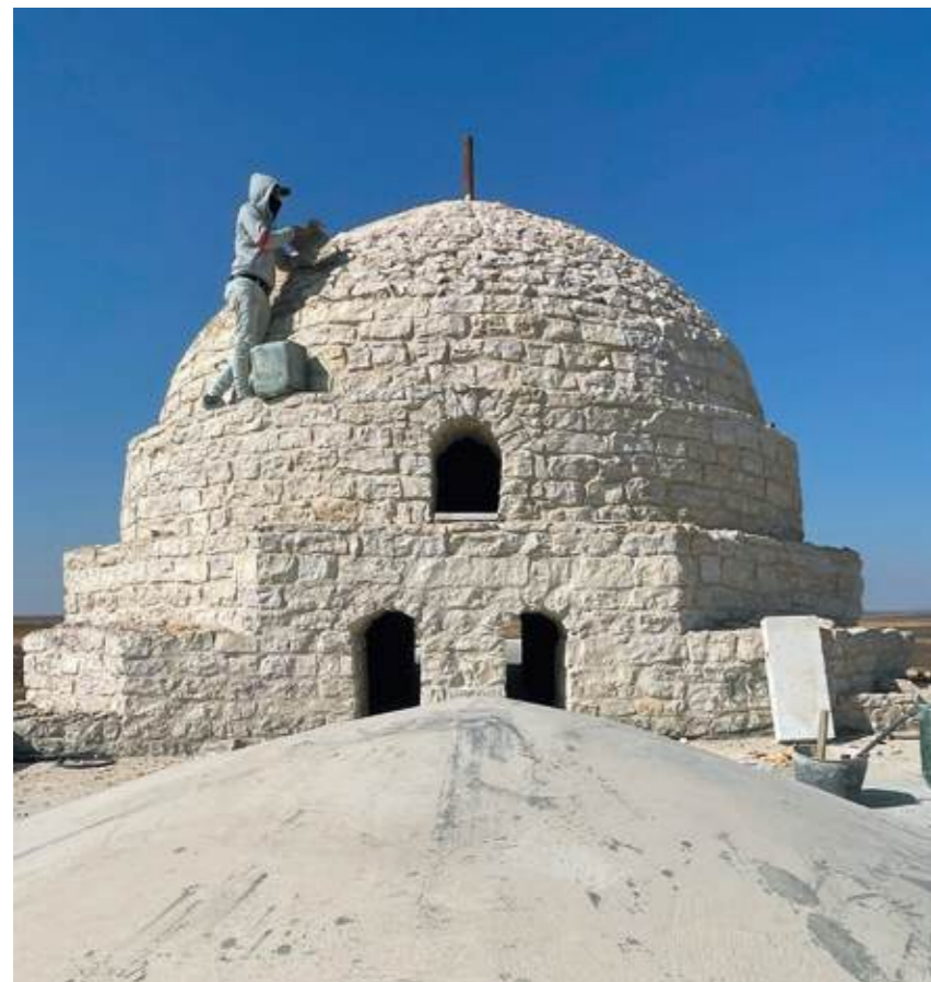
Main dome seen from the roof as a craftsman adds lime | Cúpula principal vista desde la cubierta mientras un artesano aplica cal | A cúpula principal vista do telhado enquanto o artesão adiciona a cal
