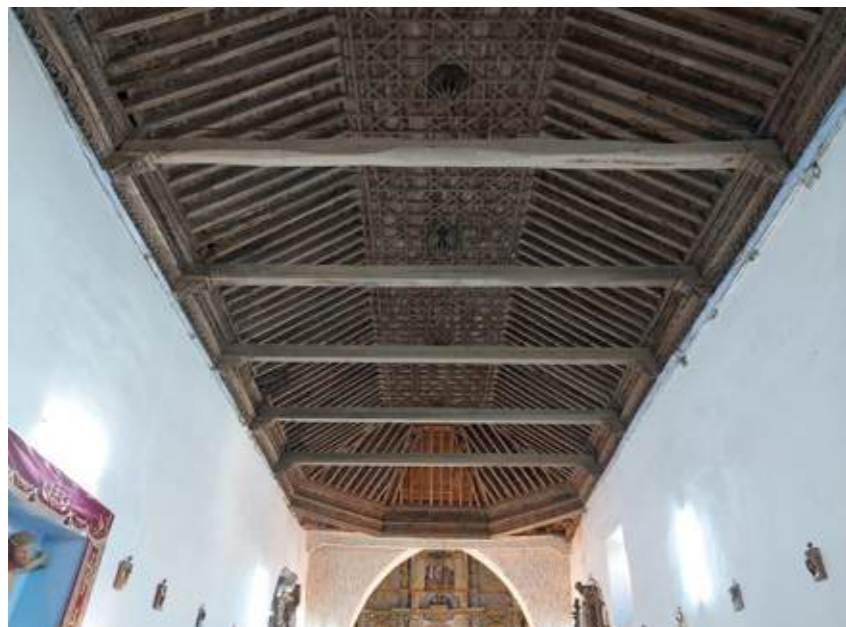
Collar-beam roof structure over the nave of the Church of Santiago Apóstol, late sixteenth century | Armadura de cubierta de par y nudillo de la nave de la iglesia de Santiago Apóstol, de finales del siglo XVI | Estrutura de treliça da cobertura da nave da igreja de Santiago Apóstol, finais do século XVI
