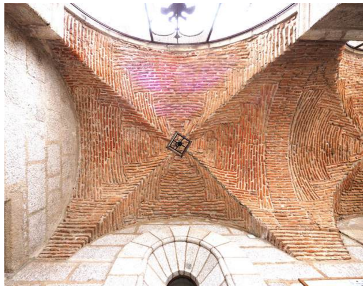
Figura 15. Bóveda en el pórtico de la Ermita de la Paz, Cáceres
