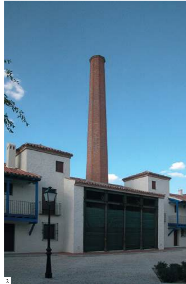
1: Common area, fountain, and trees 2: The restored chimney | 1: Espacios comunes, fuentes y arbolado 2: Vista de la chimenea restaurada | 1: Espaços comuns, fontes e arvoredado 2: Vista da chaminé restaurada
