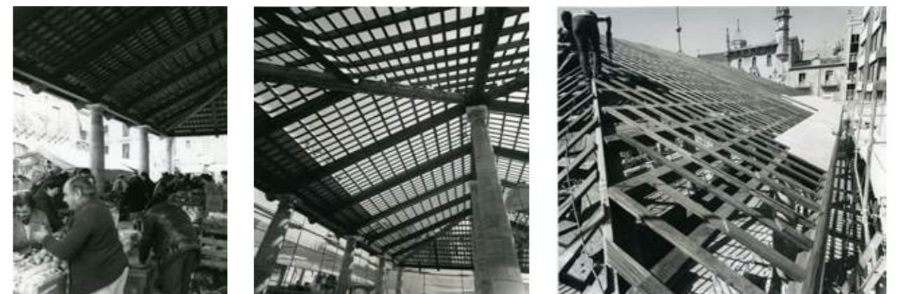
Obras de restauración de la Porxada de Granollers (Joan Francés Estorch)
