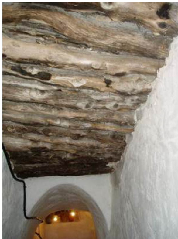
Figura 16: Ejemplos de soluciones constructivas en el cañón de acceso. De izquierda a derecha: vigas de enebro / falsa bóveda de piedra (Memoria del Plan Especial del Barrio de Bodegas del Núcleo de Baltanás)
