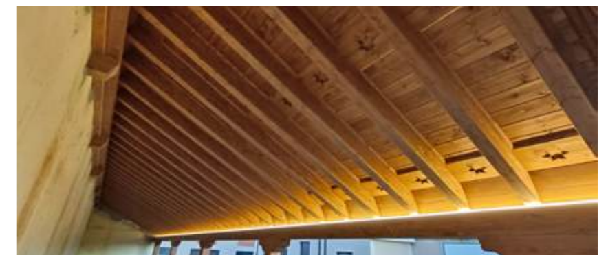
Main porch roof structure lit up | Detalle de la armadura principal del pórtico iluminada | Pormenor da cobertura principal do pórtico iluminado
