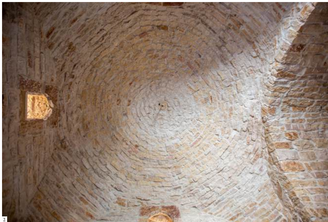
1: Vault from below with transition between the shallow dome and the main dome 2: Shallow dome / sail vault from below | 1: Bóveda vista desde abajo en la transición entre la cúpula baja y la cúpula principal 2: Cúpula baja / bóveda vaída vista desde abajo | 1: Vista inferior da abóbada. Zona de transição entre a cúpula baixa e a cúpula principal 2: Vista inferior da cúpula baixa / abóbada vazia
