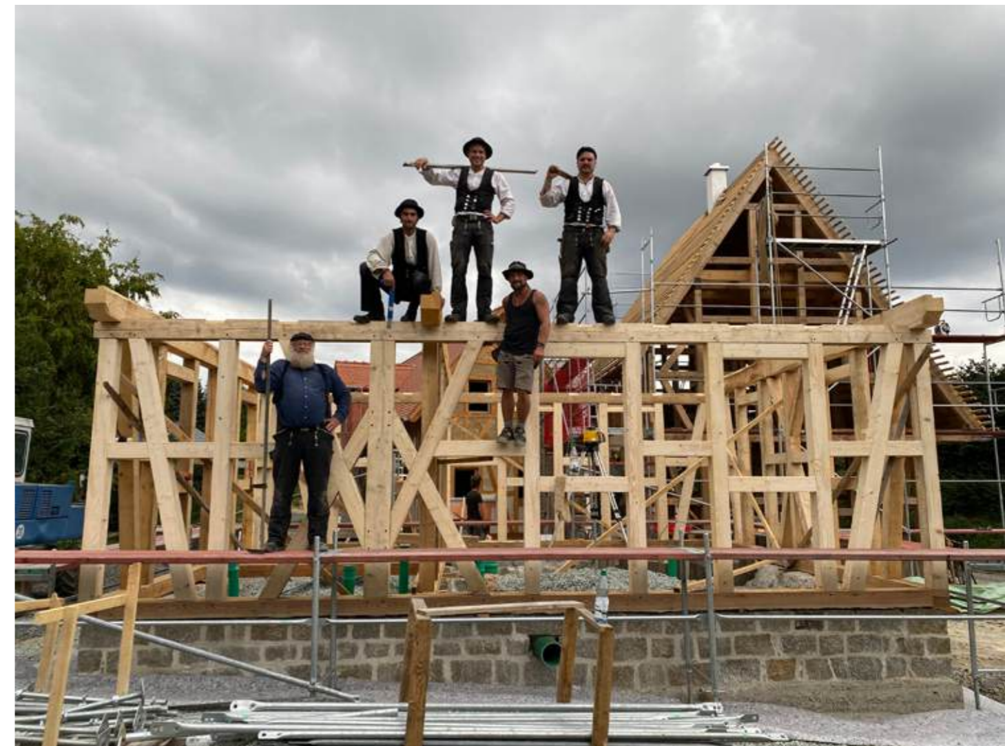
Craftsmen working on House A | Artesanos trabajando en la Casa A | Artesãos a trabalhar na Casa A (Geschichtspark Bärnau)
