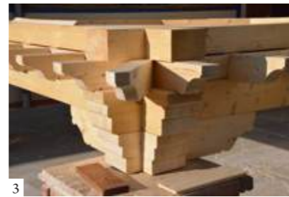
1: Carpentry workshop at the León Trades Center. Building of one slope of the new porch roof. Structural carpentry course, summer 2020 2: Workshop assembly of the new porch roof structure 3: Corner detail of the top plating for the new main porch structure, with footings, sill plates, beams, wall plates, and a corner crosspiece | 1: Taller de carpintería del Centro de los Oficios de León. Construcción de un faldón de la nueva armadura del pórtico sobre la entrada principal. Curso de carpintería de armar, verano de 2020 2: Montaje en el taller de la nueva armadura del pórtico principal para la iglesia de Santiago Apóstol 3: Detalle de la esquina del estribado de la nueva armadura del pórtico principal, con zapatas, soleras, cabezuelas, estribos y cuadril | 1: Oficina de carpintaria do Centro de Oficios de León. Construção de uma das águas do novo telhado do pórtico. Curso de carpintaria estrutural, verão de 2020. 2: Montagem na oficina da nova estrutura do pórtico principal para a igreja de Santiago Apóstol. 3: Pormenor do canto do pilar do novo reforço do pórtico principal, com sapatas, soleiras, vigas, frechais e escoras
