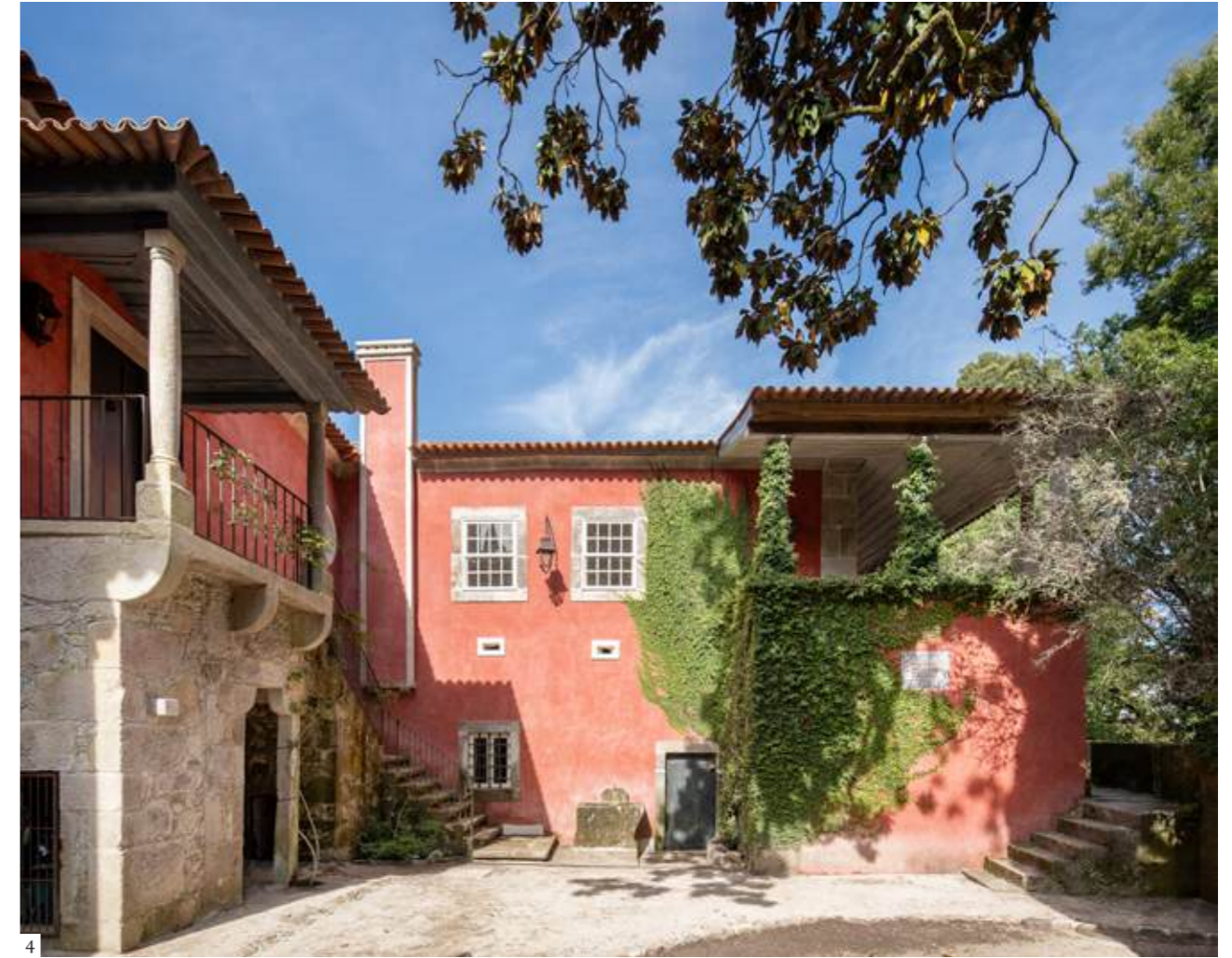
1: Northeast courtyard after restoration of the exterior steps, porch, chimneys and staircase window 2,3: Northeast courtyard before restoration 4: Northeast courtyard once restored | 1: Patio noreste tras la reintegración de la escalera exterior, el porche, las chimeneas y el ventanal de la escalera interior 2, 3: Patio noreste antes de la intervención 4: Patio noreste, después de la intervención | 1: Pátio Nordeste após a intervenção de reintegração da escadaria exterior, alpendre, chaminés e janelão da escadaria interior 2, 3: Pátio Nordeste antes da intervenção 4: Pátio Nordeste, após a intervenção (1: Maria João Gala 3: PdS, Paulo dos Sousa)
