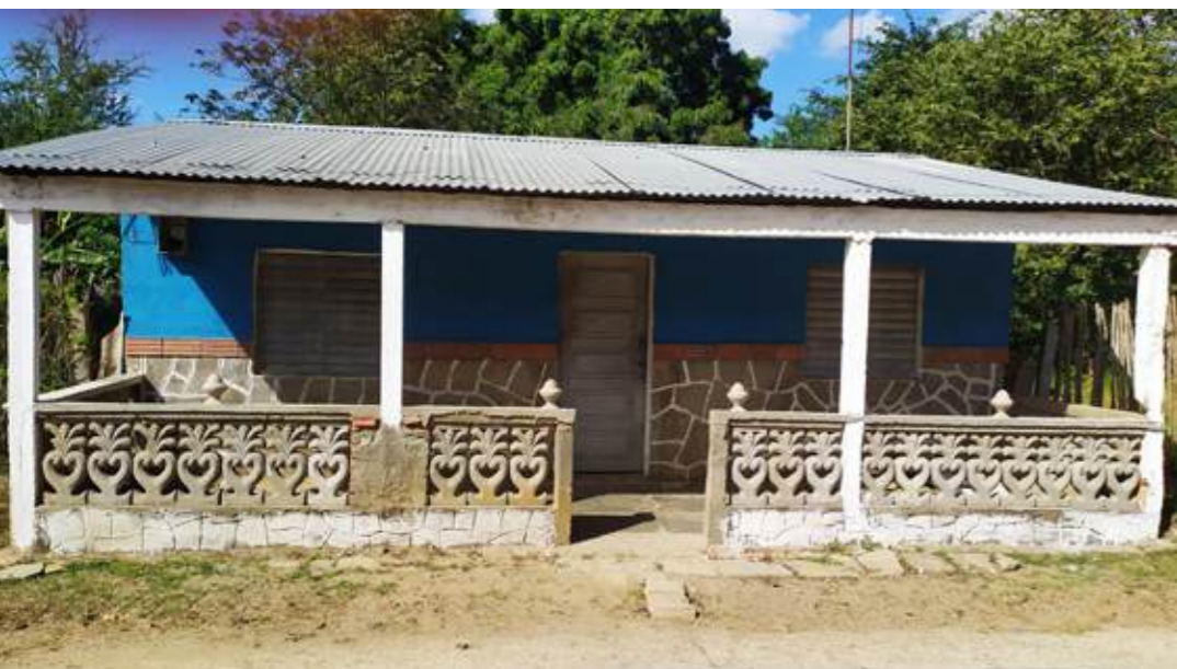
Figura 14: Viviendas en San Pedro construidas con ladrillo cocido y hormigón armado (Oficina del Conservador en Trinidad)
