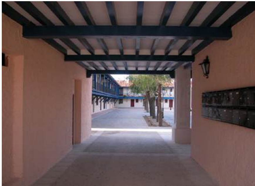
Covered passageway to the square from the exterior street | Paso cubierto de acceso a la plaza desde la calle exterior | Corredor de acesso à praça a partir da rua exterior
