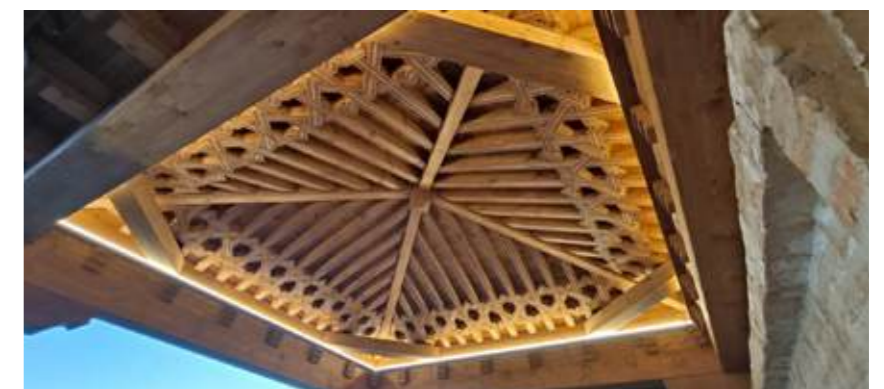
Side porch roof structure lit up | Detalle de la armadura lateral del pórtico iluminada | Pormenor da cobertura lateral do pórtico iluminado
