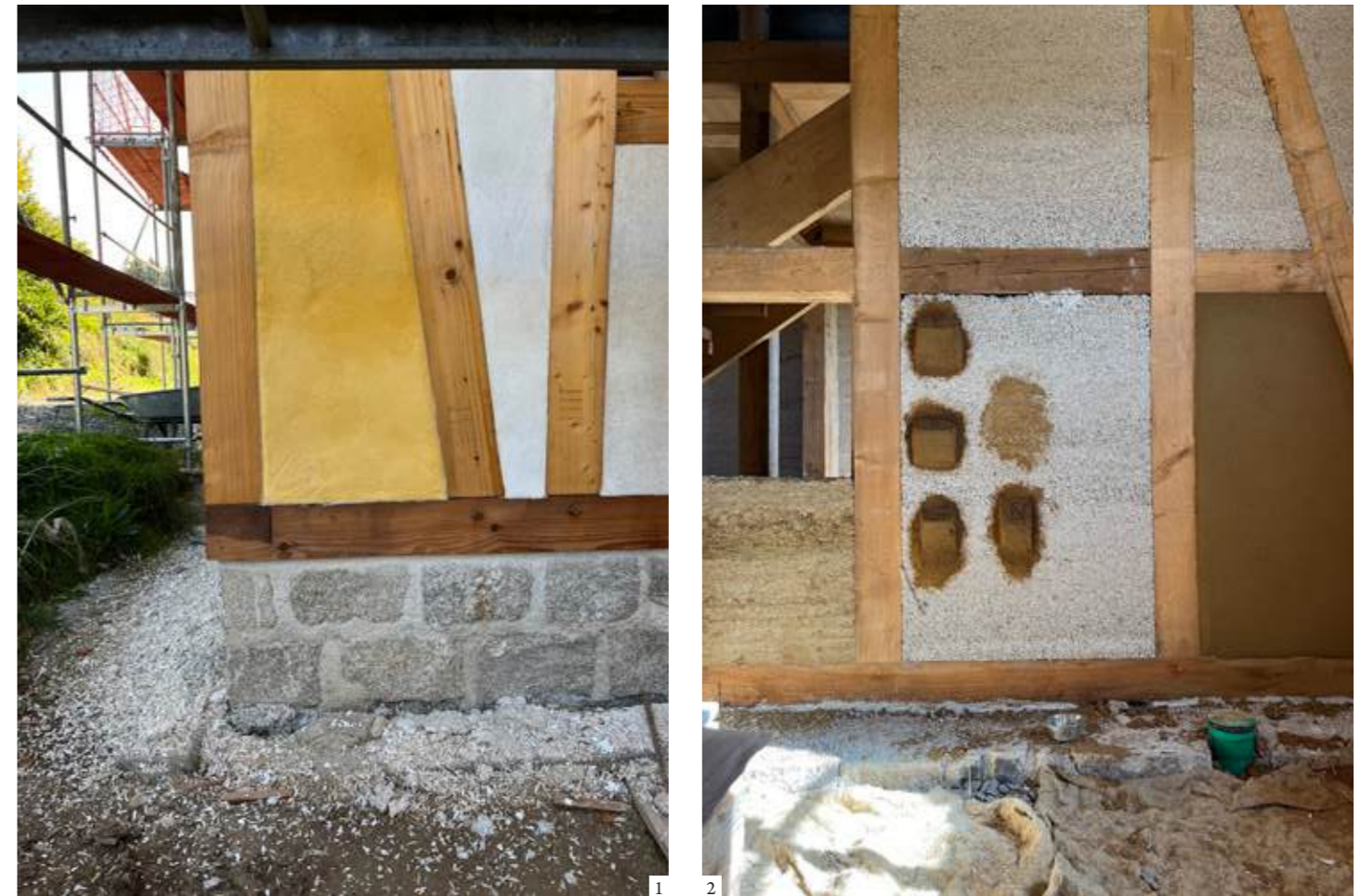
1: Lime plaster with natural pigment 2: Clay plastering | 1: Mortero de cal con pigmentos naturales 2: Revoco de arcilla | 1: Reboco de cal com pigmento natural 2: Reboco em argila
