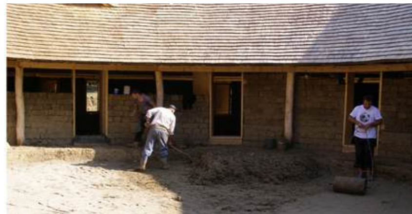
Process of building the Students' House | Proceso de construcción de la casa de los estudiantes | O processo de construção da casa do estudante
