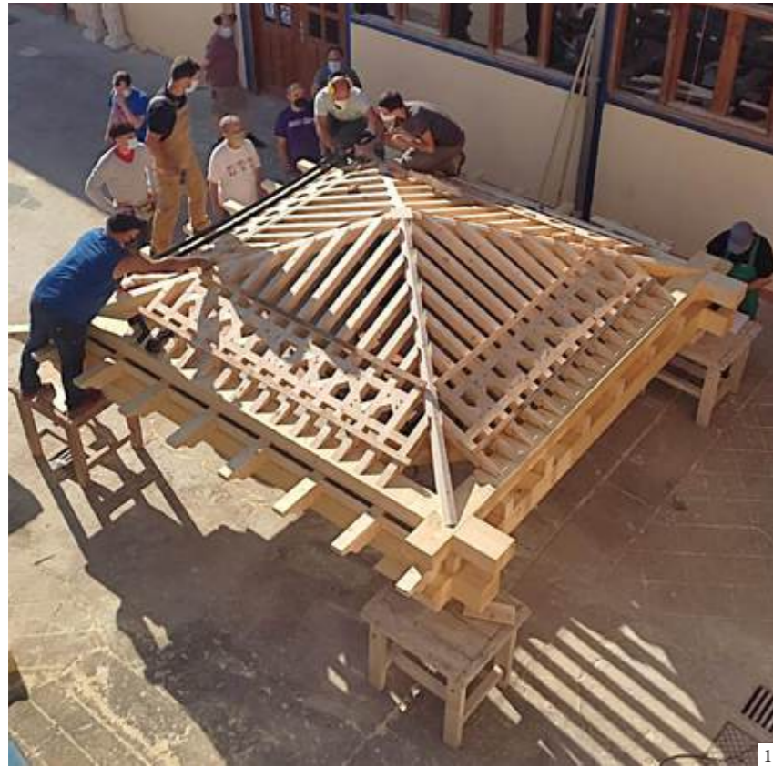
1: Carpentry workshop at the León Trades Center. Building of one slope of the new porch roof. Structural carpentry course, summer 2020 2: Workshop assembly of the new porch roof structure 3: Corner detail of the top plating for the new main porch structure, with footings, sill plates, beams, wall plates, and a corner crosspiece | 1: Taller de carpintería del Centro de los Oficios de León. Construcción de un faldón de la nueva armadura del pórtico sobre la entrada principal. Curso de carpintería de armar, verano de 2020 2: Montaje en el taller de la nueva armadura del pórtico principal para la iglesia de Santiago Apóstol 3: Detalle de la esquina del estribado de la nueva armadura del pórtico principal, con zapatas, soleras, cabezuelas, estribos y cuadril | 1: Oficina de carpintaria do Centro de Oficios de León. Construção de uma das águas do novo telhado do pórtico. Curso de carpintaria estrutural, verão de 2020. 2: Montagem na oficina da nova estrutura do pórtico principal para a igreja de Santiago Apóstol. 3: Pormenor do canto do pilar do novo reforço do pórtico principal, com sapatas, soleiras, vigas, frechais e escoras
