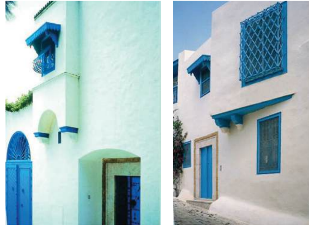
Detalles de la fachada hacia la calle
