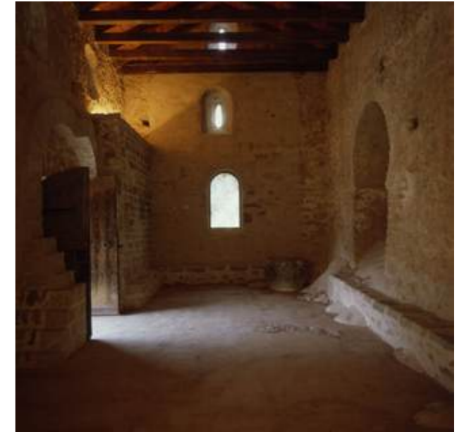
Estado previo y posterior a la intervención en el interior de la iglesia de Sant Quirze de Pedret (1: Jaume Soler 2: Montserrat Baldomà)
