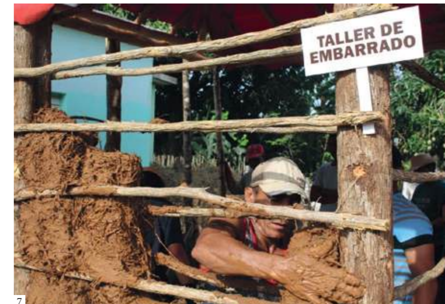
Figura 6: Mariana Herrera, directora de la Escuela de Oficios de la Oficina del Conservador, aplicando un repello de tierra en una casa típica de la localidad construida con la técnica del "embarrado", 2022
