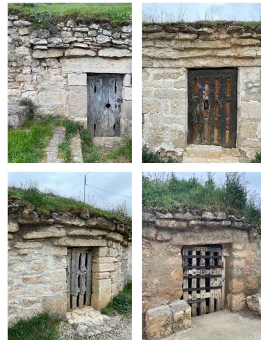
Figura 13: Hueco de acceso con dintel de enebro. Puerta de enebro, junta de canto a tope con travesaño interior (Beatriz del Río Calleja)
