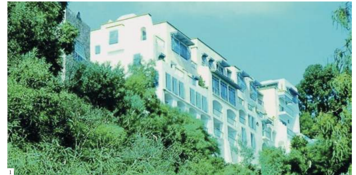
1: Fachada posterior de las tres viviendas 2, 3: Fachada hacia la calle
