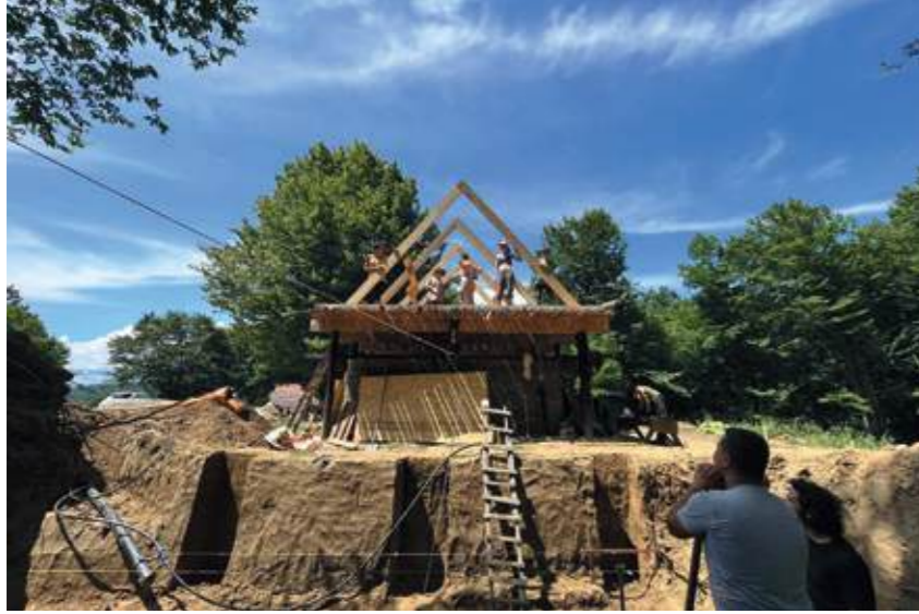
The Bath Pavilion seen from the utility room, both structures under construction | El pabellón de baño visto desde la sala de servicios, con ambas estructuras en proceso de construcción | O pavilhão de banho visto a partir da sala técnica, ambas as estruturas em construção
