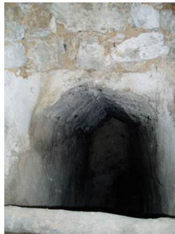
Figura 16: Ejemplos de soluciones constructivas en el cañón de acceso. De izquierda a derecha: vigas de enebro / falsa bóveda de piedra (Memoria del Plan Especial del Barrio de Bodegas del Núcleo de Baltanás)
