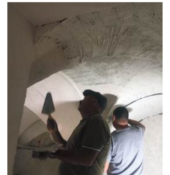
> Construction of new intersecting groin-vault ceilings | Ejecución de nuevos techos en bóveda de arista | Execução de novos tectos em abóbada de arista
