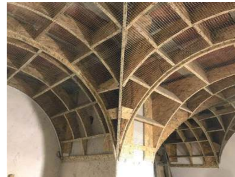
> Construction of new intersecting groin-vault ceilings | Ejecución de nuevos techos en bóveda de arista | Execução de novos tectos em abóbada de arista
