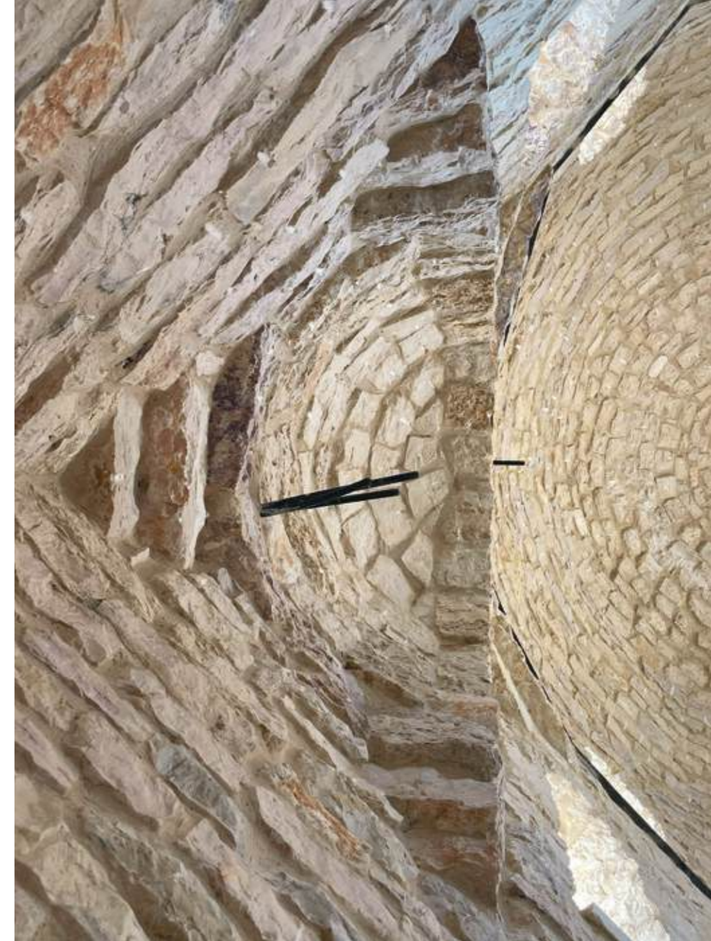
Squinch seen from below, triangle in plan, converting the square to an octagon | Trompa vista desde abajo, de planta triangular, que convierte el cuadrado en un octágono | Vista inferior da trompa de ângulo, triângulo em planta, conversão do quadrado em octógono
