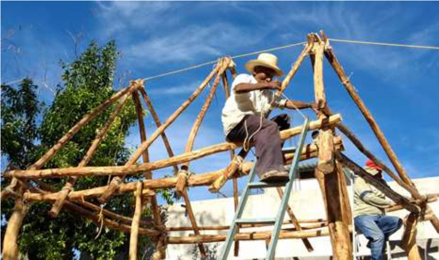
< Amarre de las sobresoleras a las “tijeras” con mecate de ixtle
