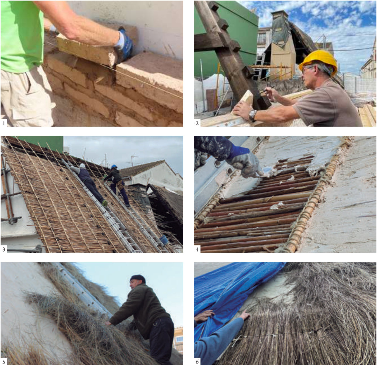
1: Process of exterior lining of the adobe walls—made of clay and rice straw—connected to the existing structure using cane notched in the form of a double harpoon and an earthen mortar enriched with lime 2: Layout of the wooden roof by the carpenter 3: Construction of the reed panel reinforced with canes 4: Application of the gypsum infill over the first reed layer of the roof slopes 5: Thatching process of the roof with bundles of marram grass 6: Detail of the roof thatching with bundles of marram grass | 1: Proceso de trasdosado exterior de los muros de adobe, fabricados con barro y paja de arroz, conectado al existente con cañas melladas en forma de arpón y con mortero de tierra enriquecido con cal 2: Replanteo de la cubierta de madera por el carpintero 3: Construcción del tablero de carrizo reforzado con cañas 4: Proceso de aplicado del rehenchido de yeso sobre el primer tablero de carrizo de los faldones de cubierta 5: Proceso de techado de la cubierta con haces de barrón 6: Detalle del techado de la cubierta con haces de barrón | 1: Processo de revestimento exterior das paredes de adobe, fabricadas com barro e palha de arroz, ligadas à estrutura existente com canas fendidas em forma de arpão e argamassa de terra enriquecida com cal 2: Marcação da cobertura de madeira pelo carpinteiro 3: Construção do painel de caniço reforçado com canas 4: Aplicação do enchimento de gesso sobre o primeiro painel de caniço das águas da cobertura 5: Processo de cobertura do telhado com feixes de carriço 6: Detalhe da cobertura do telhado com feixes de carriço (S: Rosaleny)
