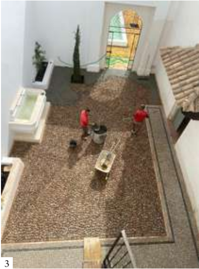
1: Support corbels for the eaves made by Miguel Ángel Balmaseda 2: Restoration of the brickwork in the spandrel 3: Process of cobbling and paving the open carriage porch | 1: Ménsulas de apoyo del tejazoz realizadas por Miguel Ángel Balmaseda 2: Restauración del ladrillo de la enjuta 3: Proceso de empedrado y enchinado del apeadero descubierto | 1: Mísulas de suporte do beiral executadas por Miguel Ángel Balmaseda 2: Restauo do tijolo na enjuta 3: Processo de empedramento e calçada da cocheira descoberta (1: Miguel Ángel Balmaseda 2: Sebastián Pérez Gómez 3: Urbipac)
