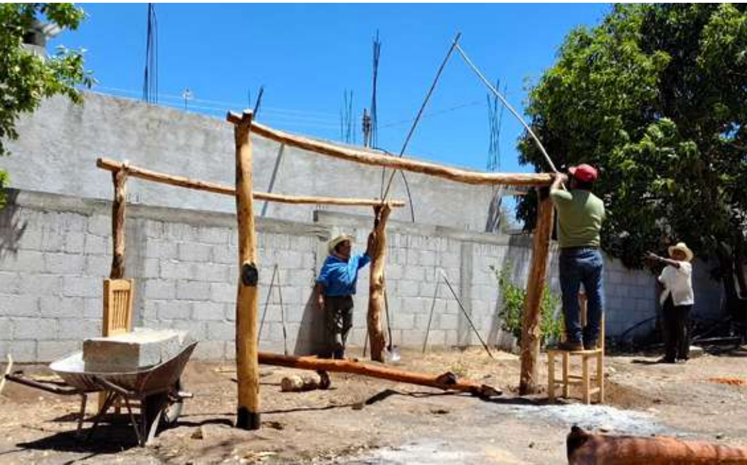
Vista en planta de la estructura con horcones y soleras (Paulina Monroy)
