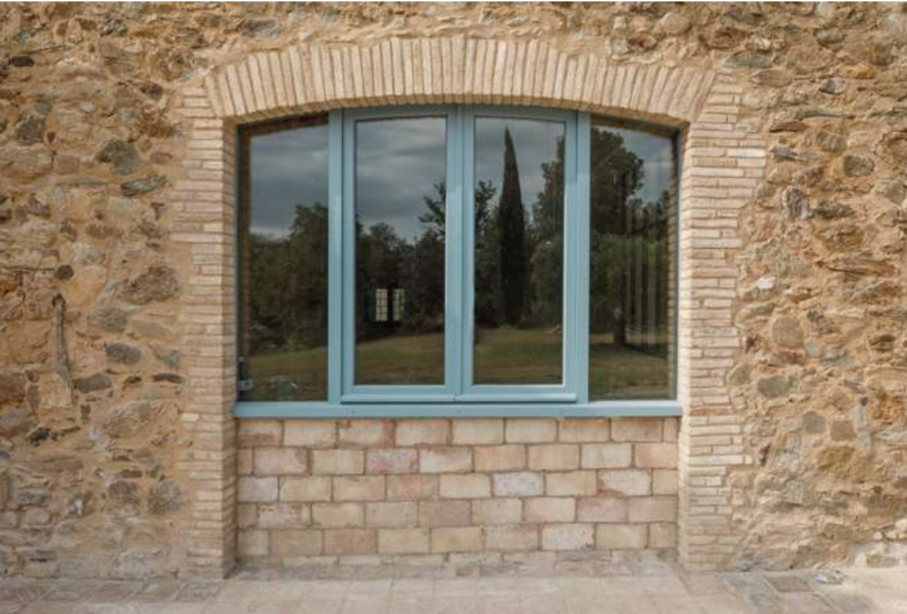
Old doorway converted into a living room window | Antiguo portal reconvertido en ventanal de la sala de estar | Antigo portal transformado em janela da sala de estar (Antonio Navarro Wijkmark)
