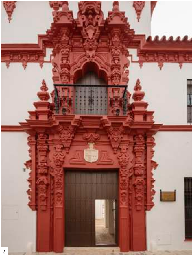
Main doorway of the Casa Palacio before and after the intervention | Portada de la Casa Palacio antes y después de la intervención | Portal da Casa Palácio antes e depois da intervenção (1: Urbipac 2: Fernando Alda)
