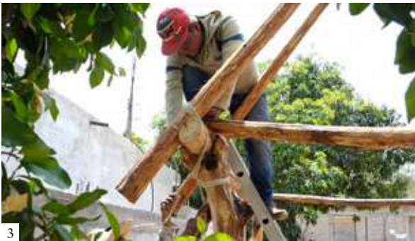
1. Ensamble de ramas de sauce que forman una “tijera”, atadas con ixtle. 2. Vista del ángulo interno del ensamble de una “tijera”. 3. Amarre que fija la intersección entre horcón, soleras y “tijeras”. 4. Detalle del amarre de la “tijera” a la solera.
