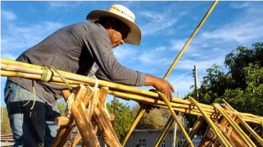
> Doblado de carrizos en la cabeza de la casa para formar el entramado vertical
