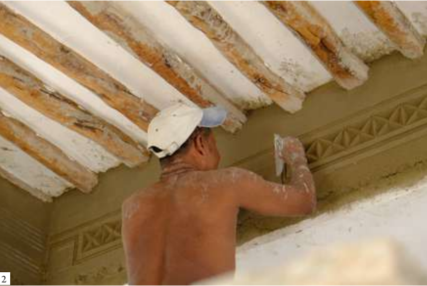
1: Swahili decorative work on traditional niches 2: Swahili decorative work on moldings 3: Tools, including spoons, used for decorative work | 1: Trabajos decorativos suajilis en nichos tradicionales 2: Trabajos decorativos suajilis en molduras 3: Herramientas, incluyendo cucharas, para los trabajos decorativos | 1: Trabalhos decorativos suailis em nichos tradicionais 2: Trabalhos decorativos suailis em molduras 3: Ferramentas, incluindo colheres, usadas nos trabalhos decorativos
