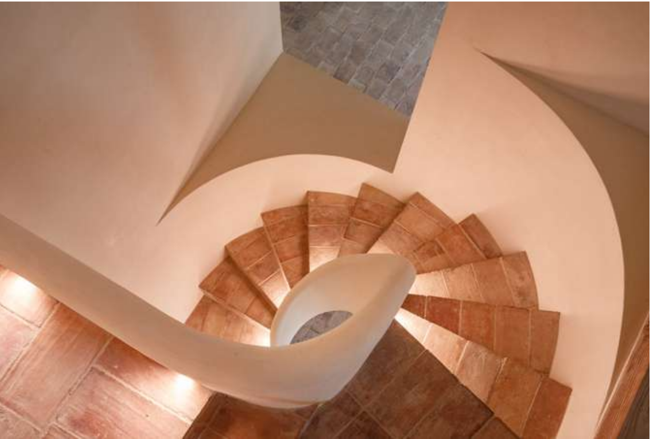
Thin-tile vaulted staircase coated with lime plaster and with handmade ceramic steps | Escalera de bóveda tabicada revocada con cal y con peldaños de cerámica artesanal | Escada de abóbada de tijolo revestida com cal e com degraus de cerâmica artesanal (Antonio Navarro Wijkmark)
