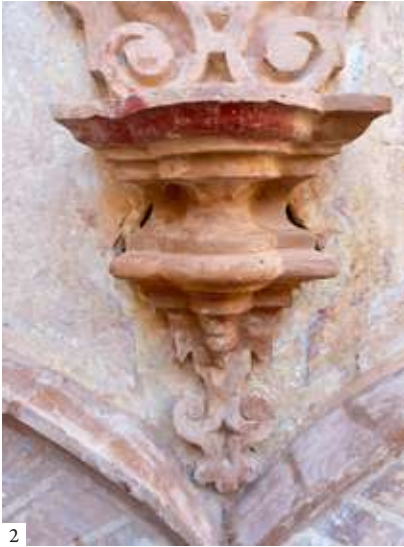
1: Support corbels for the eaves made by Miguel Ángel Balmaseda 2: Restoration of the brickwork in the spandrel 3: Process of cobbling and paving the open carriage porch | 1: Ménsulas de apoyo del tejazoz realizadas por Miguel Ángel Balmaseda 2: Restauración del ladrillo de la enjuta 3: Proceso de empedrado y enchinado del apeadero descubierto | 1: Mísulas de suporte do beiral executadas por Miguel Ángel Balmaseda 2: Restauo do tijolo na enjuta 3: Processo de empedramento e calçada da cocheira descoberta (1: Miguel Ángel Balmaseda 2: Sebastián Pérez Gómez 3: Urbipac)
