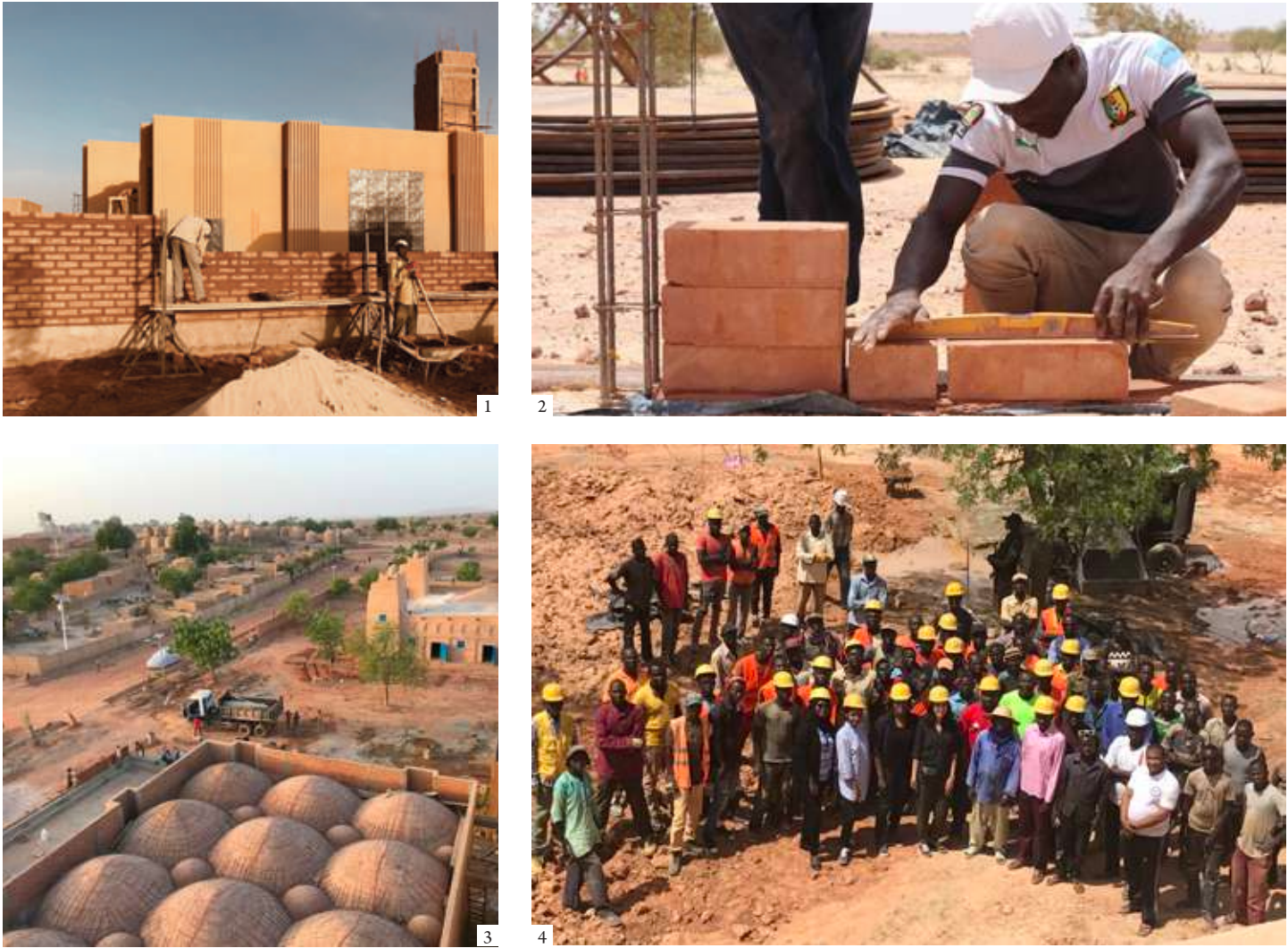
1, 2: Construction with compressed earth blocks 3: View of the extrados of the CEB vaults 4: Work team | 1, 2: Construcción con bloques de tierra comprimida 3: Vista del trasdós de las bóvedas de BTC 4: Equipo de trabajo | 1, 2: Construção com blocos de terra comprimida 3: Vista do extradós das abóbadas de BTC 4: Equipa de trabalho
