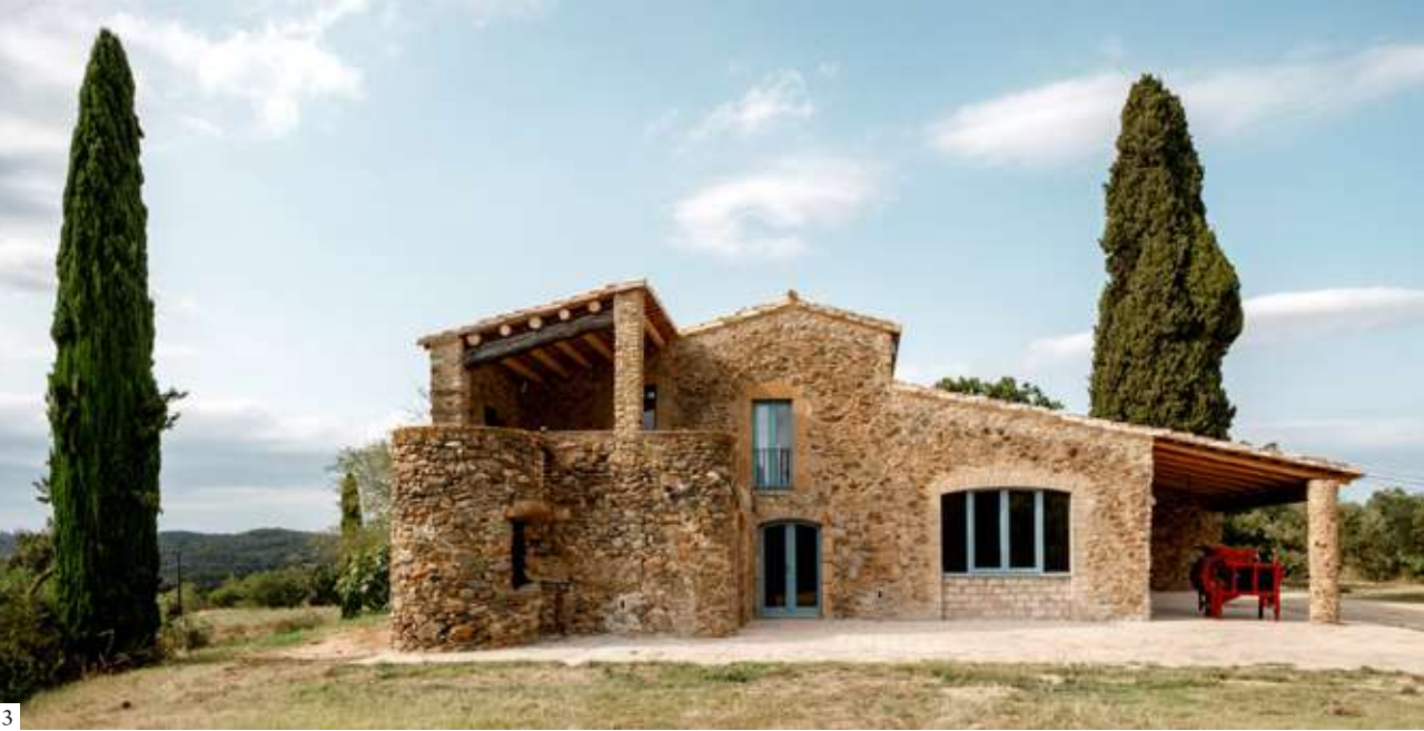
Main façade before and after the restoration | Fachada principal antes y después de la intervención | Fachada principal antes e depois da intervenção (1, 2: Archivo Bangolo 3: Antonio Navarro Wijkmark)
