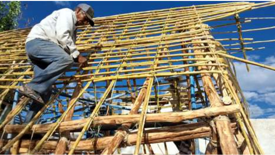
Planta de la estructura y del entramado de carrizos del techo (Paulina Monroy)
