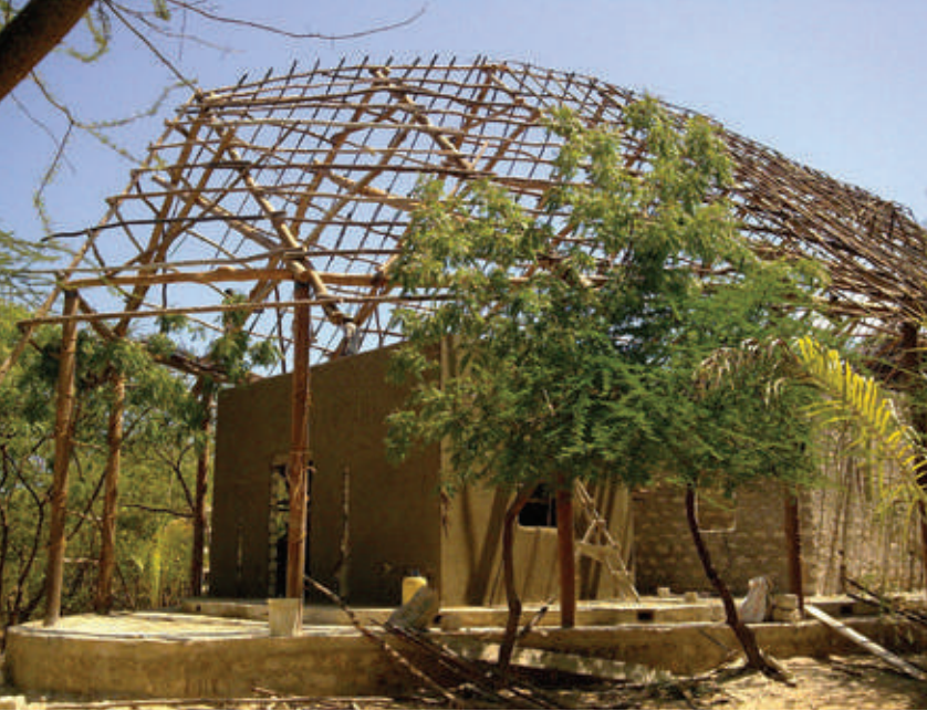
Makuti wooden structure during construction | Estructura de madera de makuti durante la construcción | Estrutura de madeira de makuti durante a construção
